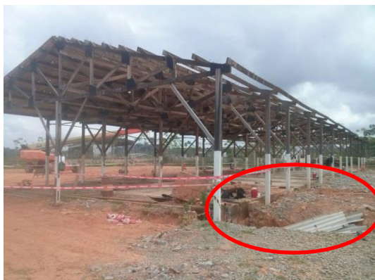
Figura 3 - Imagem do ponto antes da retirada de solo.
