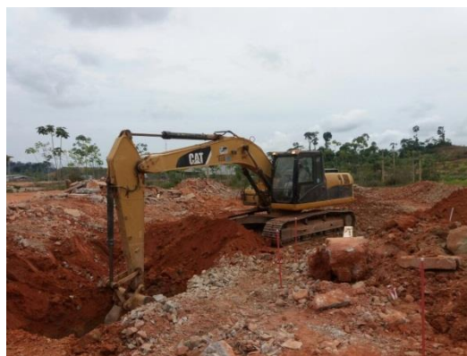
Figura 4 - Retirada de solo do ponto contaminado.
