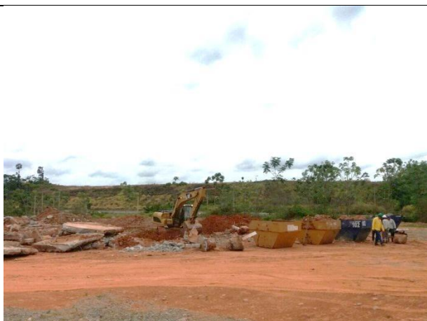
Figura 5 - Caçambas com o solo contaminado.
