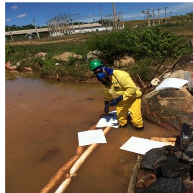
Figura 18: Remoção de óleo através das mantas de absorção no trecho a montante do dreno de comunicação com o reservatório.
