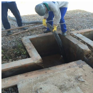
Figura 25: Descontaminação das caixas de passagem.
