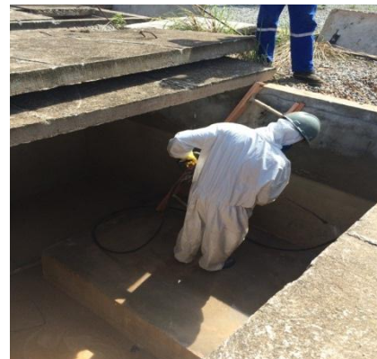
Figura 26: Higienização caixa S.A.O próximo aos transformadores.
