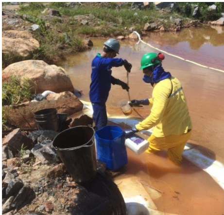
Figura 19: Remoção de óleo com coletor no trecho a montante do dreno de comunicação com o reservatório.
