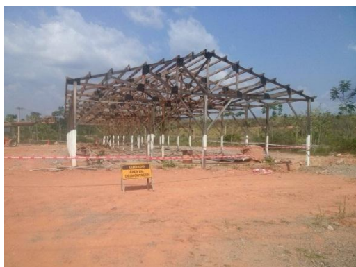
Figura 39: Desmontagem da cobertura da subestação
