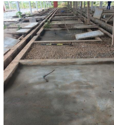
Figura 28: Bases dos transformadores descontaminadas.
