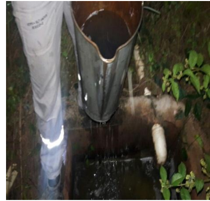
Figura 12: Remoção do óleo da caixa S.A.O próximo ao canal durante turno noturno.
