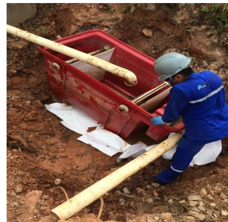
Figura 24: Instalação da caixa S.A.O Alpina.
