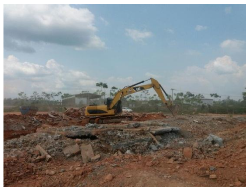
Figura 40: Remoção dos pisos das bases dos transformadores, geradores e canaletas.
