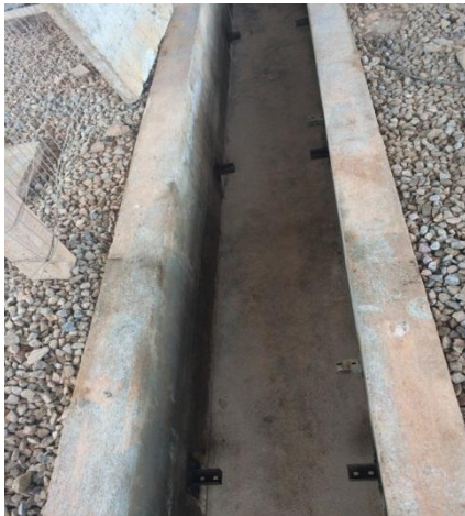
Figura 29: Canaletas de drenagem descontaminadas.
