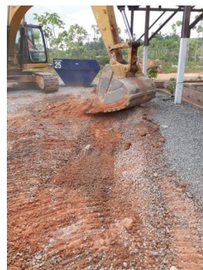
Figura 34: Raspagem do solo contaminado;
