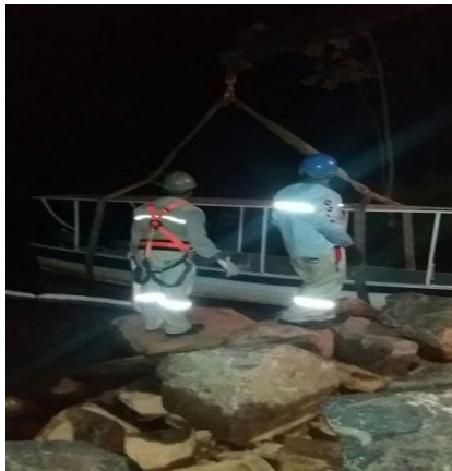
Figura 13: Mobilização de barco para instalação de barreira de contenção.
