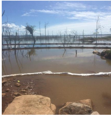
Figura 21: Vista da água no trecho do canal a jusante do dreno de comunicação com o reservatório.
