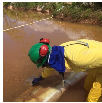
Figura 20: Remoção de óleo com coletor no trecho a montante do dreno de comunicação com o reservatório.
