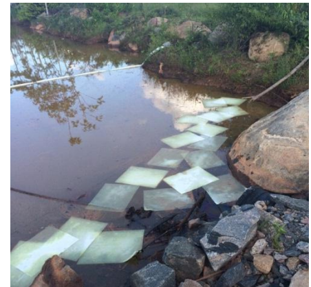
Figura 10: Colocação de mantas absorventes no trecho do canal a montante do dreno de comunicação com o reservatório.
