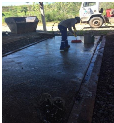
Figura 23: Descontaminação pisos das bases dos geradores.
