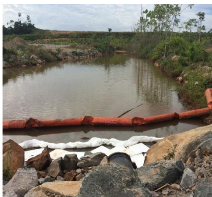
Figura 31: Trecho do canal a montante do dreno de comunicação com o reservatório sem a presença de óleo.
