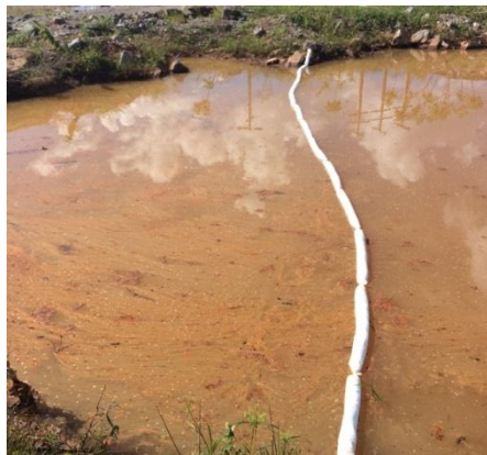
Figura 09: Colocação da primeira barreira de absorção no trecho a montante do dreno de comunicação com o reservatório.
