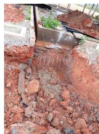
Figura 36: Abertura de cava para investigação de passivos ambientais.
