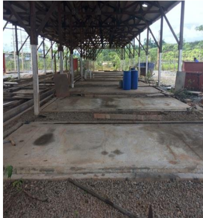
Figura 27: Base dos geradores descontaminadas.
