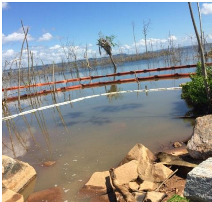
Figura 17: vista das barreiras de absorção e contenção no trecho do canal a jusante do dreno de comunicação com o reservatório.
