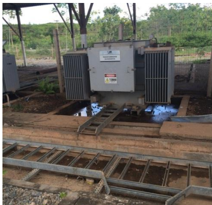
Figura 03: Transformador de elevação danificado, com vazamento de óleo.
