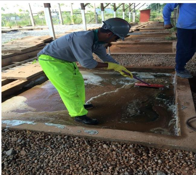
**Figura 05:** Descontaminação pisos das bases dos transformadores – Subestação Hematita – Sítio Pimental – Julho 2017
