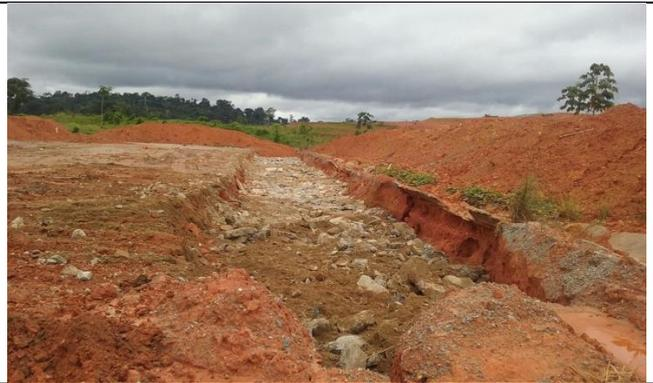
**Figura 34:** Vala para aterro dos resíduos de concreto.
