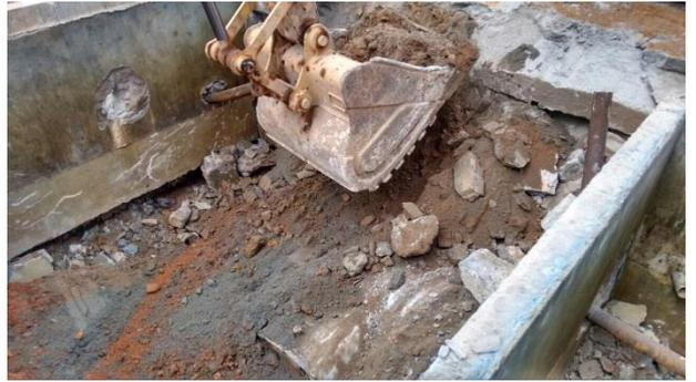
**Figura 38:** Remoção tanque subterrâneo Posto de Abastecimento – PI – Outubro/17
