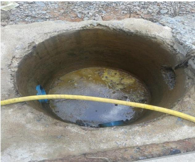
**Figura 11:** Caixa de passagem Oficina de Lubrificação após descontaminação – PI - Agosto/17
