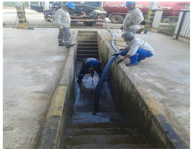
**Figura 10:** Higienização e descontaminação das rampas de lubrificação – PI – Agosto/17
