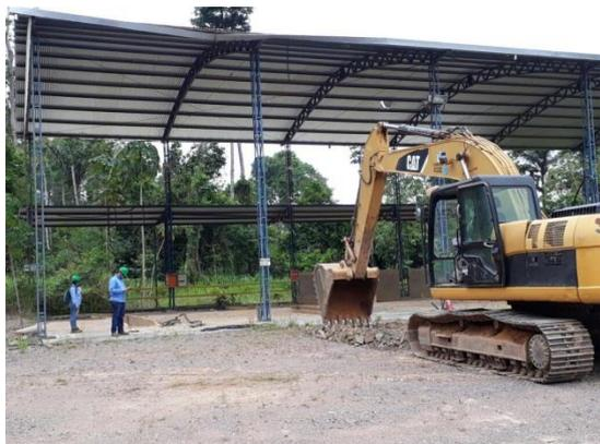
**Figura 29:** Investigação passivos ambientais – Abertura de vala para análise dos gases e coleta de amostra de solo- Oficina MMK – CD – Setembro/17
