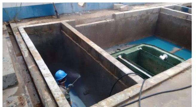
**Figura 36:** Descontaminação caixa S.A.O Posto de Abastecimento – PI – Outubro/17
