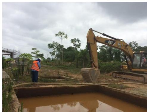
**Figura 26:** Investigação passivos ambientais – Abertura de vala para análise de gases no solo e coleta de amostra de solo – Bacia de Sedimentação Oficina Mecânica Ilha Marciana – PI – Setembro/17
