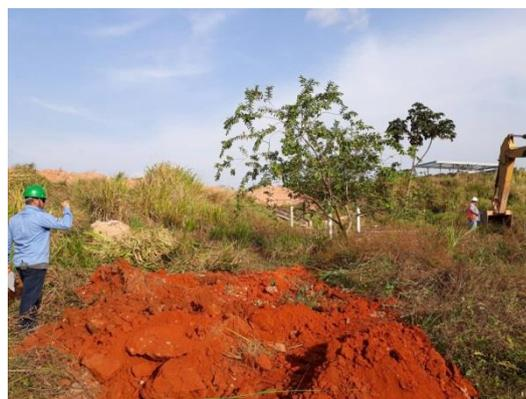
**Figura 30:** Investigação passivos ambientais – Abertura de vala para análise dos gases e coleta de amostra de solo- Ponto de Lançamento do efluente – Oficina e Rampas de Lavagem - BV – Setembro/17
