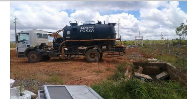
**Figura 23:** Escritório Central em processo de desmobilização Caixa de Acumulação de Efluentes Sanitários.
