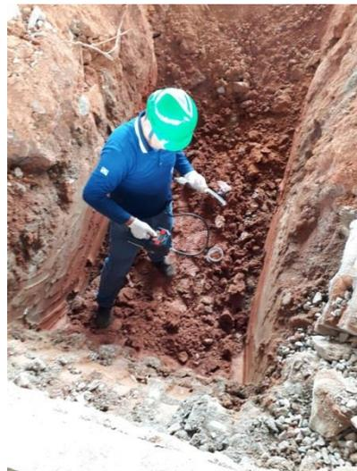
**Figura 22:** Investigação passivos ambientais – Análise dos gases no solo – Subestação Hematita – PI – Setembro/17
