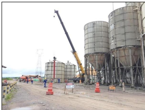
**Figura 06:** Acompanhamento do processo de desmobilização de silos da Central de Concreto em Belo Monte. Fev/17
