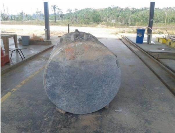
**Figura 39:** Tanque subterrâneo após remoção – PI – Outubro/17
