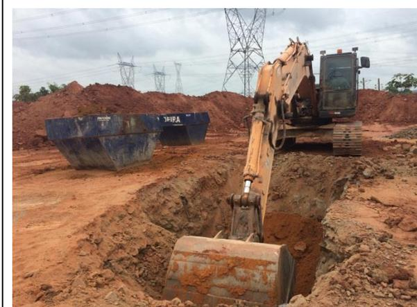
**Figura 45:** Remoção do solo contaminado na Oficina de Guindastes e Telebelts conforme pluma de contaminação definida no laudo de passivos ambientais – BM – Novembro/17
