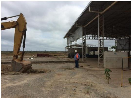
**Figura 25:** Investigação passivos ambientais – Abertura de vala para análise de gases no solo e coleta de amostra de solo – Oficina Mecânica Ilha Marciana – PI – Setembro/17
