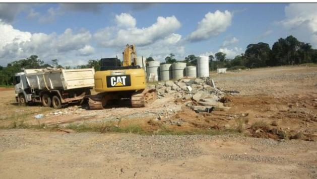
**Figura 47** – Compactação e remoção do solo.
