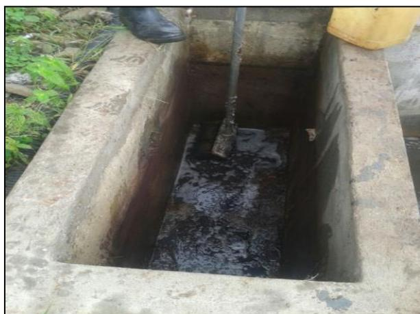
**Figura 09:** Acompanhamento do processo de Desmobilização de caixa SAO da rotatória da Ilha da Marciana. Fev/17.
