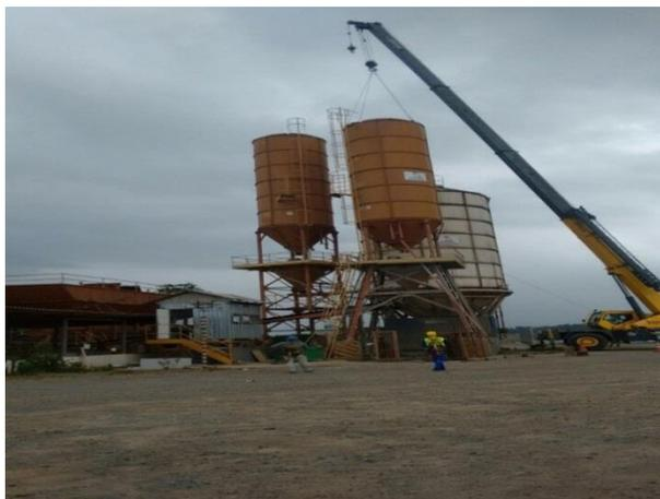
**Figura 23:** Desmontagem da Central de Concreto – Canteiro Bela Vista – Jun/2017
