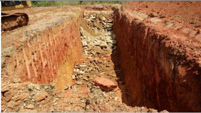
**Figura 33:** Vala para aterro dos resíduos de concreto.
