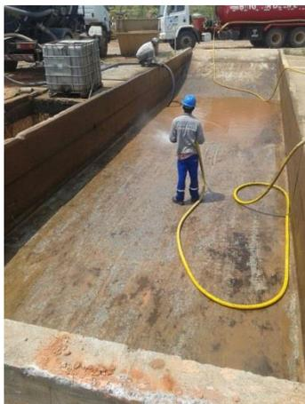
**Figura 23:** Descontaminação caixa de sedimentação– Rampa de lavagem central – PI – Setembro/17
