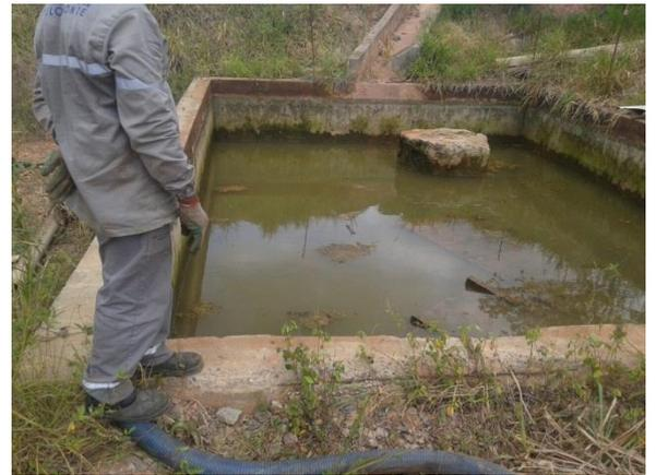
**Figura 32:** Esgotamento caixa de sedimentação Oficina Central – BV – Outubro/17
