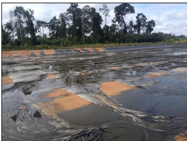
**Figura 05:** Atividade de Corte das mantas PAD na desmobilização da ETE de Canais e Diques. Jan/17
