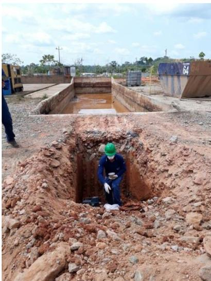
**Figura 17:** Investigação passivos ambientais – Coleta de amostra de solo – Rampa de lavagem central – PI – Setembro/17
