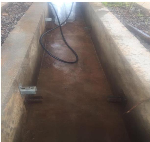
**Figura 06:** Descontaminação canaletas subestação Hematita – Sítio Pimental – Julho 2017
