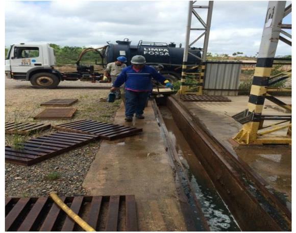
**Figura 08:** Higienização e descontaminação das canaletas da oficina central – PI – Agosto/17
