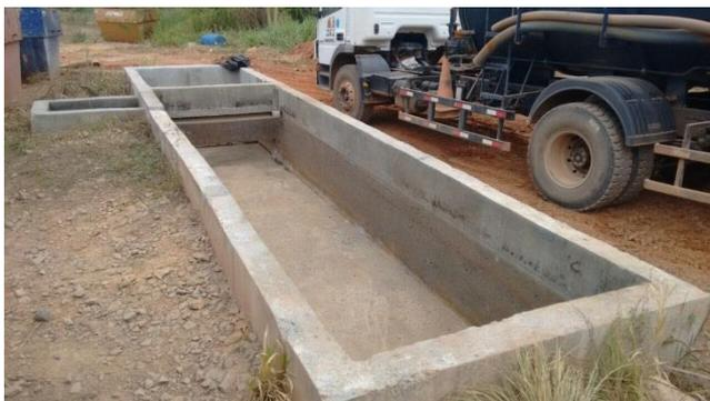
**Figura 35:** Caixa S.A.O Oficina Central após descontaminação – BV – Outubro/17
