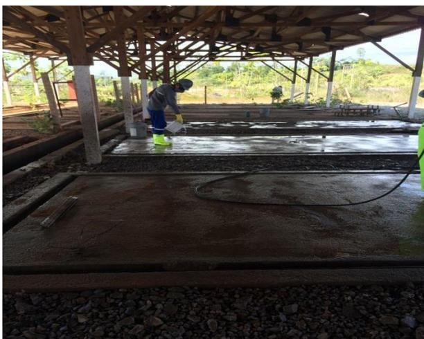
**Figura 04:** Descontaminação pisos das bases dos geradores Subestação Hematita – Sítio Pimental – Julho 2017
