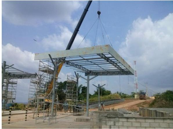
**Figura 31:** Retirada das estruturas de sustentação da cobertura do Posto de Bela Vista – BV – Outubro/17
