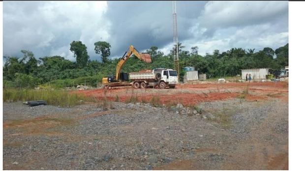
**Figura 29:** Remoção do piso de contenção ao lado do escritório.
