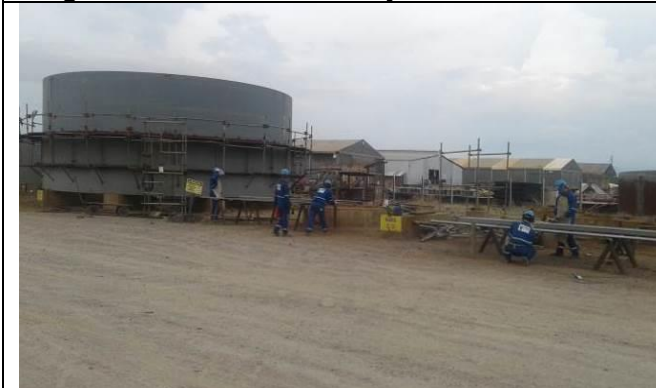
Figura 40: Pátio de Premontagem – Outubro.
