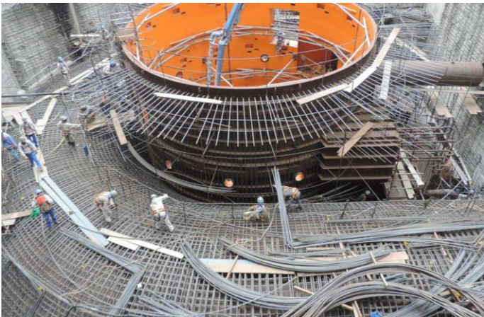
Figura 15: Armação caixa espiral 11 CF - BM - Setembro/17
