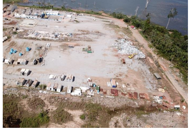
Figura 38: Desmontagem das estruturas do Almojarifado Pimental – Dezembro/2017
