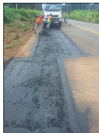
Figura 18: Acompanhamento das atividades de correção asfáltica nos acessos dos Travessões 27 e 55 dos canteiros de obra da UHE-BM. Abr/2017.
