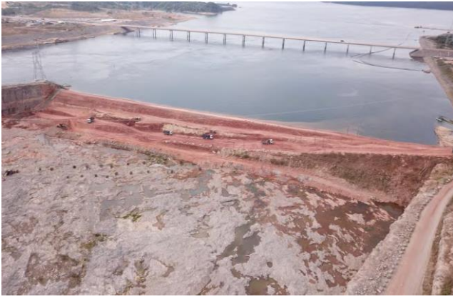
Figura 31: Remoção a seco da ensecadeira de 3ª fase – BM – Novembro/17
