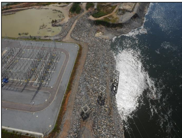
Figura 05 – Acompanhamento das atividades na Subestação definitiva de Pimental. Jan/17
