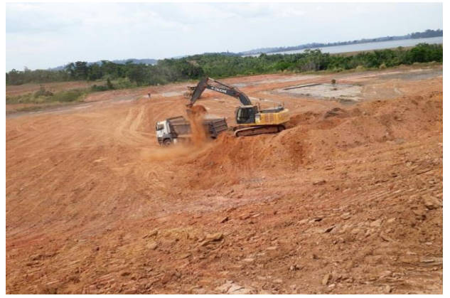
Figura 32: Conformação canteiro Bela Vista – BV – Novembro/17
