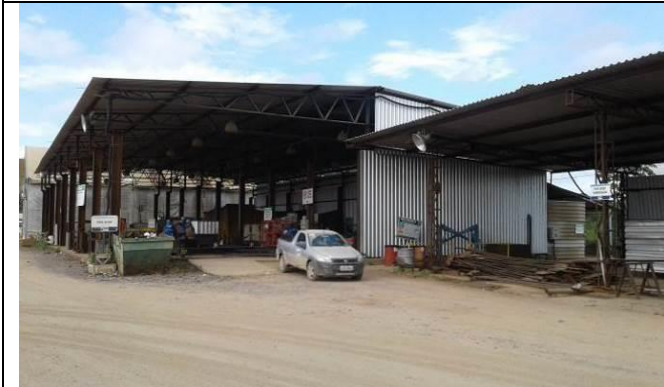
Figura 26: Galpões Oficina e Pipe Shop – Julho.
