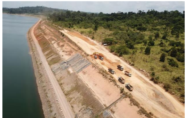
Figura 24: Reparo talude do KM 9,5 – CD – Outubro/17
