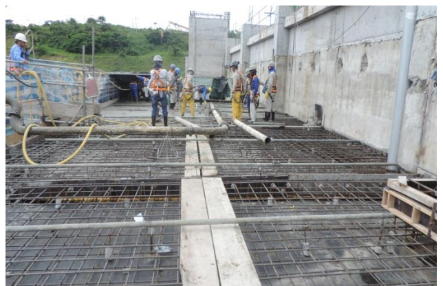
Figura 24: CF 15 e 16 preparação para concretagem da laje - Mai/2017
