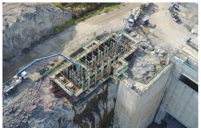
Figura 18: Lançamento de concreto revestimento de paredes elev. 13,90 CF - BM - Setembro/17
