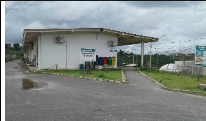
Figura 16: Área administrativa, alojamento – Abril.
