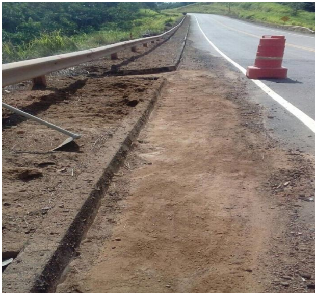
Figura 05: Atividade de limpeza de canaleta Travessão 27 – Julho/17
