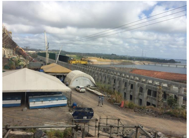
Figura 04: Vista do novo canteiro de apoio CG II – Julho/17
