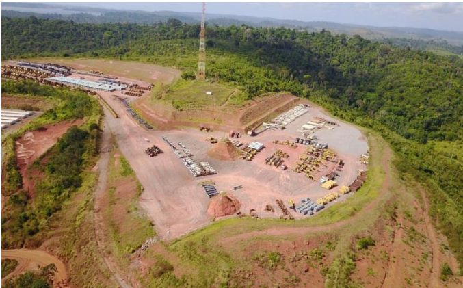
Figura 09: Imagem aérea pátio de desmobilizados – BM – Agosto/17
