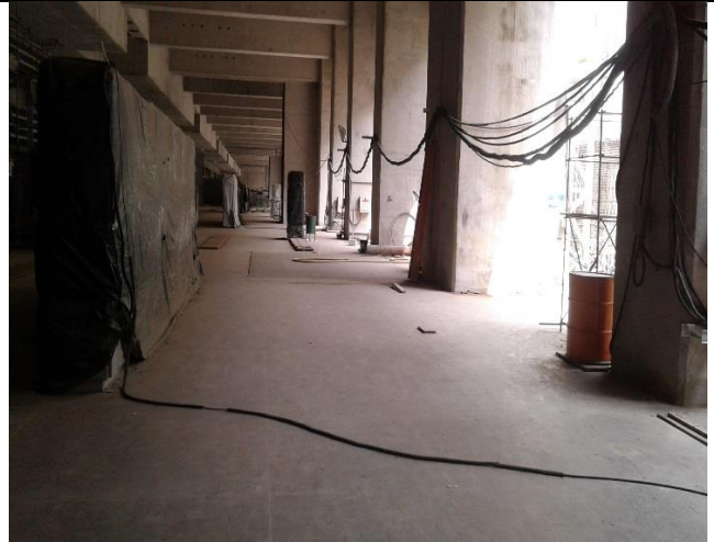
Figura 51: Área de Montagem Elétrica-Dezembro.
