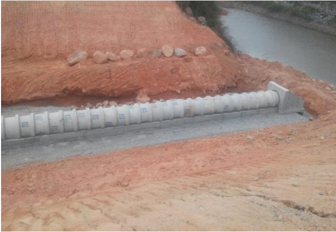
Figura 01: Bueiro Definitivo Sítio Pimental – Julho/17
