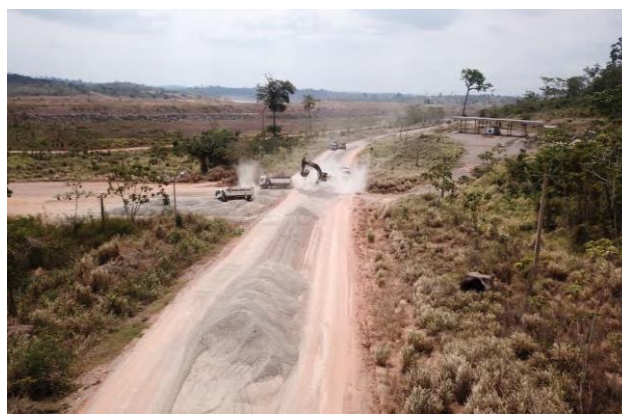
Figura 30: Pavimentação Travessão 27 – CD – Novembro/17
