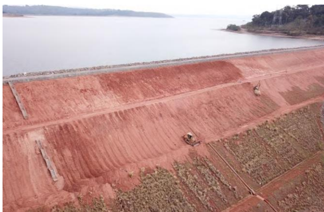
Figura 29: Correção de processo erosivos talude da Barragem de Fechamento Esquerda – Novembro/17
