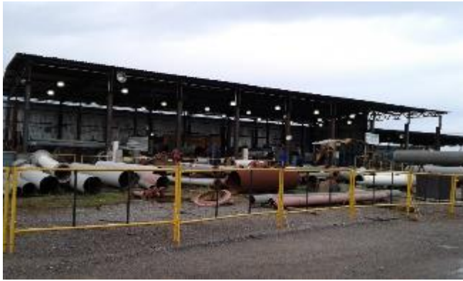
Figura 07: Oficina Pipe Shop - Janeiro.
