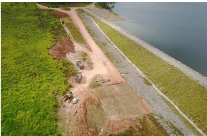
Figura 17: Execução filtro invertido Dique 11- Diques - Setembro/17
