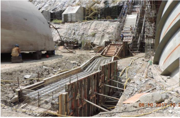
Figura 19: Montagem de forma convencional conduto forçado 09 – BM – Outubro/17
