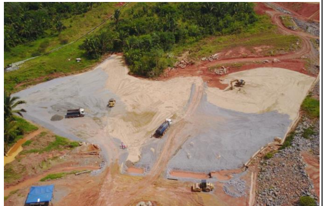
Figura 22: Execução filtro invertido Dique 8A– BM – Outubro/17
