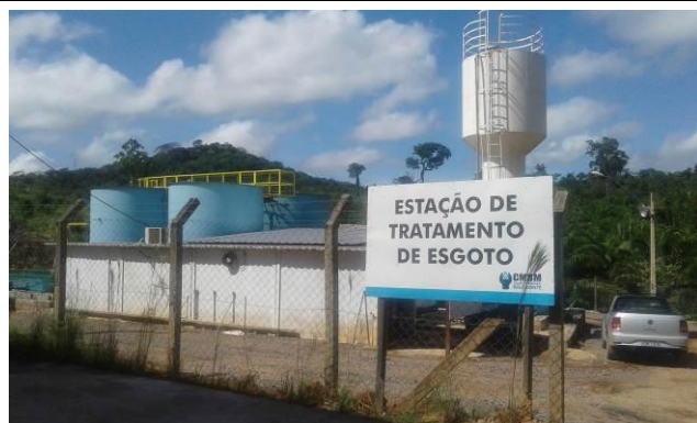
Figura 25: Estação de Tratamento de Efluentes Sanitário – Junho.
