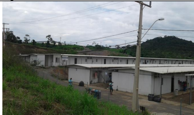
Figura 24: Alojamento CMBM-Bloco Manjoleiro- Junho.
