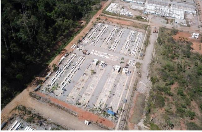
Figura 37: Remoção das estruturas de alojamentos de Pimental – Dezembro/2017
