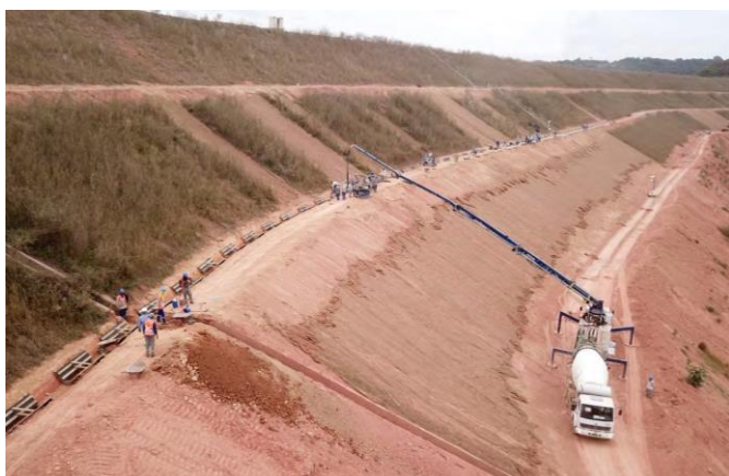
Figura 27: Execução de drenagem no Dique 8A – BM – Novembro/17
