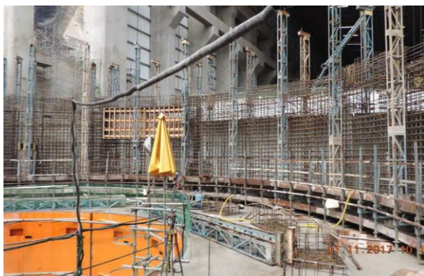
Figura 25: Montagem de forma convencional e deslizante parede do Gerador 11 – BM – Novembro/17
