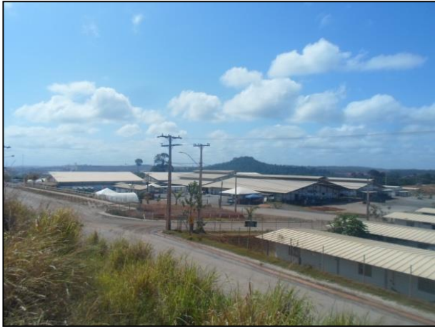
Figura 09: – Estruturas definitivas do Acampamento UHE Belo Monte. Fev/17
