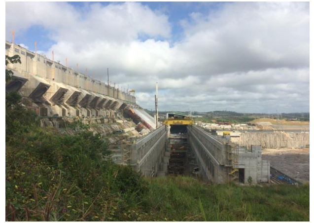
Figura 02: Vista Casa de Força II – Julho/17
