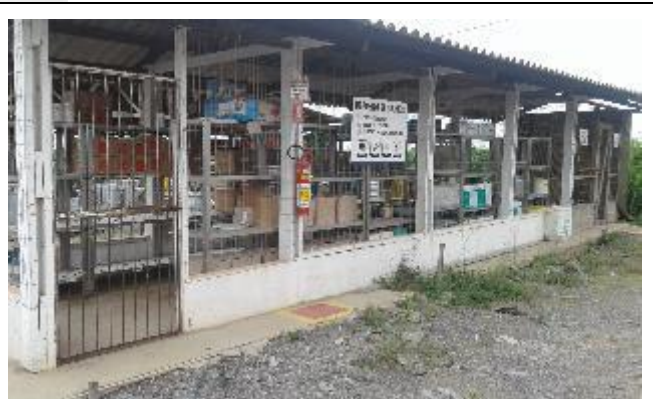
Figura 15: Deposito de Produto Químico – Março.
