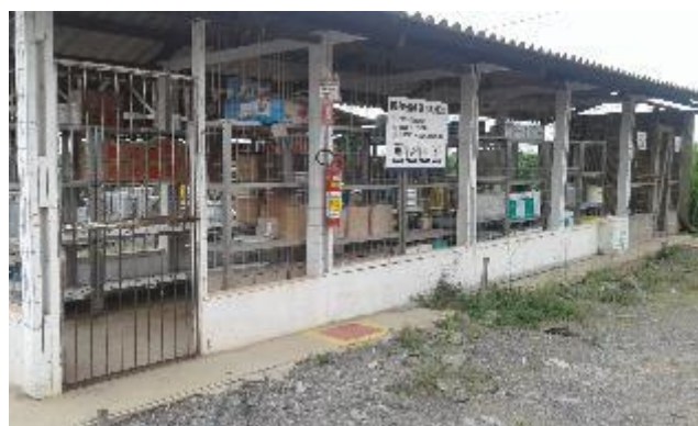
Figura 15: Deposito de Produto Químico – Março.
