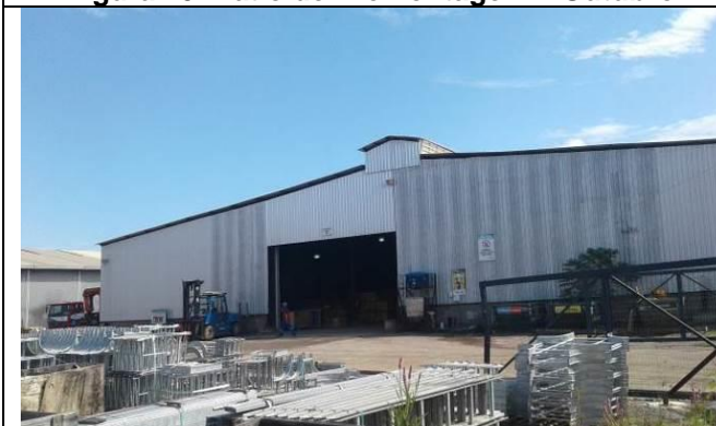
Figura 42: Galpão de Almoarifado – Outubro.
