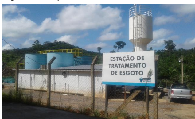
Figura 25: Estação de Tratamento de Efluentes Sanitário – Junho.
