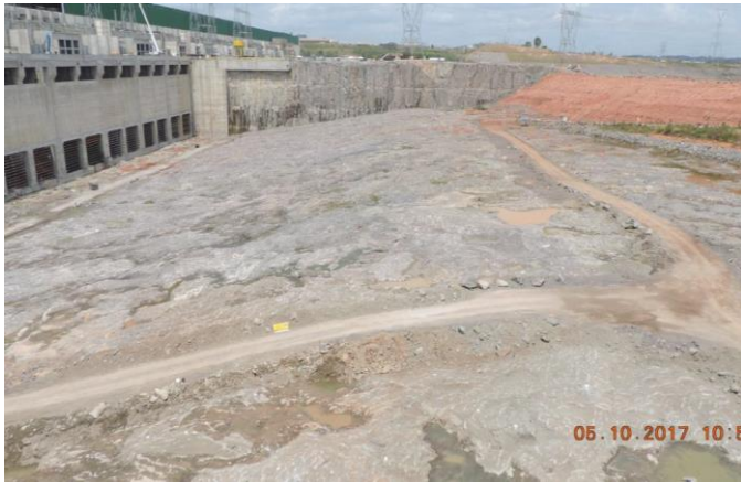
Figura 21: Conclusão da limpeza do Canal de Fuga CFII – BM – Outubro/17
