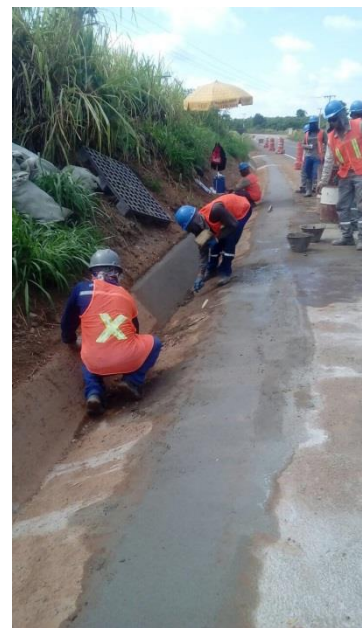
Figura 12: Atividade de reparo das canaletas de drenagem – Travessão 27 –Setembro/17
