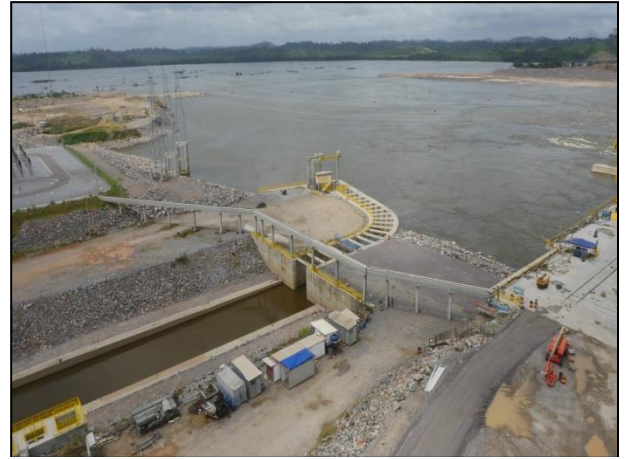
Figura 02 – Acompanhamento do avanço das atividades no canal de entrada do STP nas estruturas definitivas de Pimental. Jan/17
