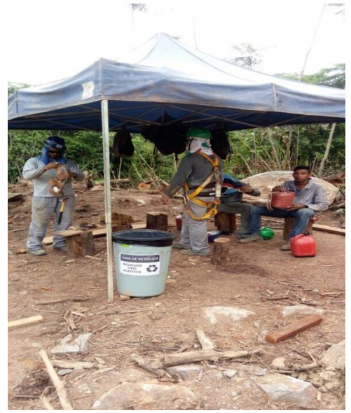
Figura 08: Frente de serviço – Linhão – Dez/17
