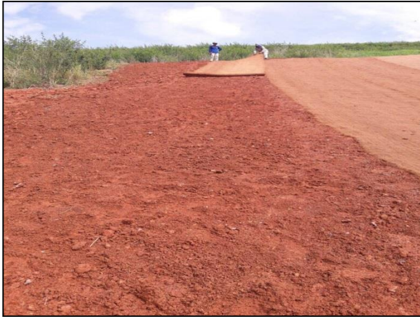
Figura 19: Aplicação de biomantas nos taludes dos Diques na UHE BM – Abr/2017.
