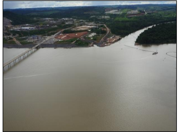
Figura 08: Visão área do Canal de Fuga Acompanhamento UHE Belo Monte. Fev/17.
