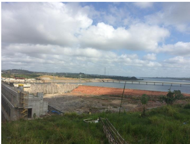
Figura 03: Vista Canal de Fuga CG II – Julho/17
