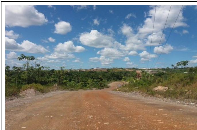
Figura 25 – Manutenção de acessos com implantação de descidas d'água - Mai/2017
