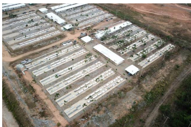
Figura 28: Desmontagem dos blocos de alojamento do condomínio Roxinol – PI – Novembro/17
