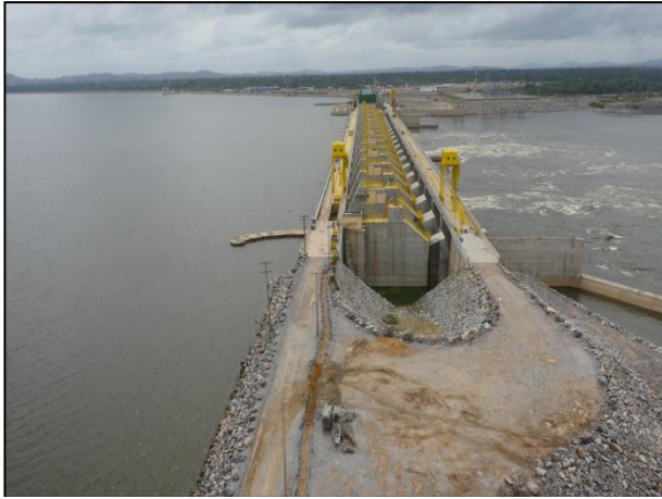
Figura 01 – Visão das estruturas definitivas pela Margem Direita na unidade de Pimental. Jan/17
