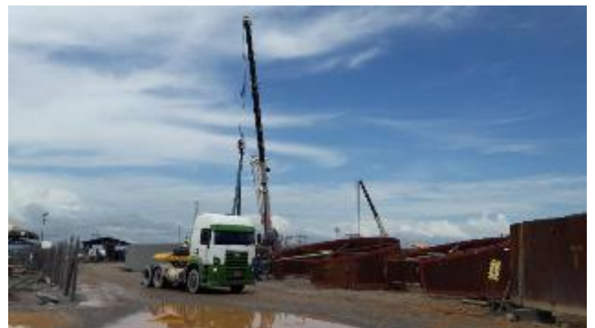
Figura 12: Pátio de Pré Montagem– Fevereiro.
