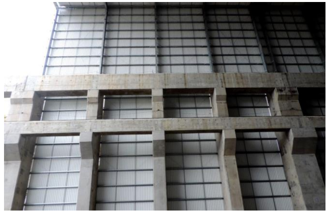
Figura 14: Conclusão da montagem da cobertura metálica lateral eixo A CF - Setembro/17
