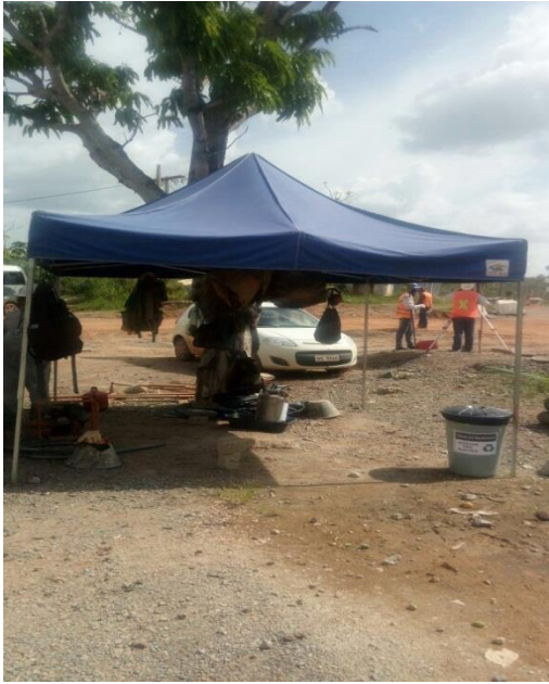
Figura 07: Frente de serviço – Linhão – Nov/17
