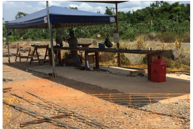
Figura 04: Armação – Canteiro Central – Out/17
