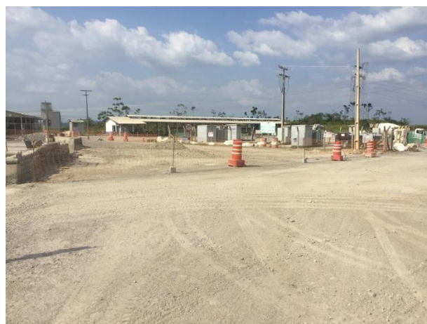
Figura 02 – Sinalização de área com uso de cones e cerquites – Outubro/17
