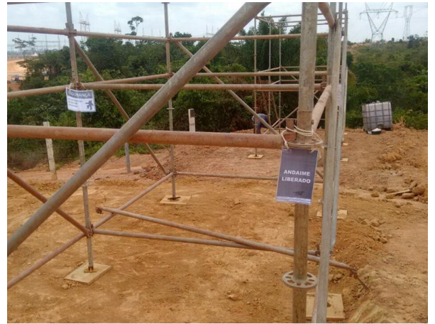
Figura 02 – Sinalização de liberação de andaimes – Dezembro/17
