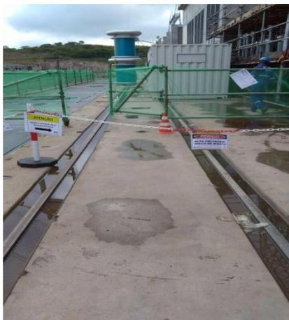
Figura 5: Sinalização de Segurança – Isolamento de área – Teste de Tensão Aplicada
