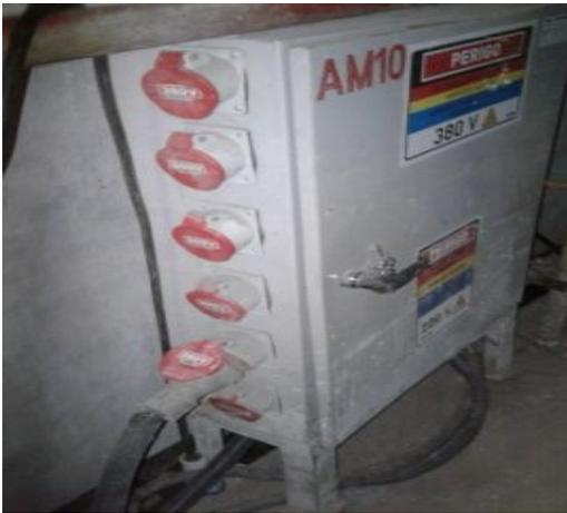
Figura 9: Painel elétrico o AM10 com aterramento elétrico danificado
