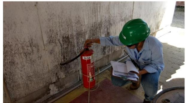
Figura16: Inspeção de extintor de incêndio
