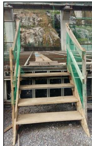
Figura 18 – Reaproveitamento de madeiras para construção de escadas de acesso nas estruturas definitivas. BM Jun/2017.
