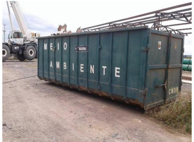
Figura 48 – Caçamba para disposição temporária de resíduos gerados no canteiro de obras e frente de serviço.
