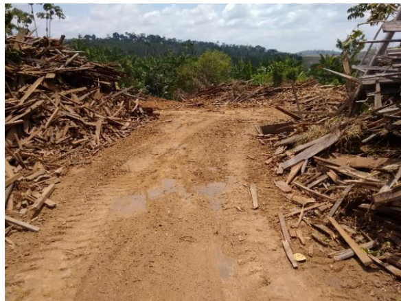
Figura 5.2-2 – Aceiro aberto entre resíduos mais suscetíveis ao fogo (à direita), e área mais distante do foco inicial (à esquerda), para dificultar a propagação do incêndio (combate indireto) – área a leste
