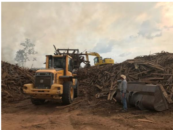
Figura 5.2-5 – Finalização da abertura de aceiro com uso de carregadeira de pneus da DWE e escavadeira hidráulica do CCBM
