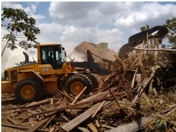
Figura 5.2-1 – Carregadeira de pneus retirando resíduos para formação de aceiro (combate indireto) – área a leste do monte de pó de serra
