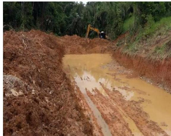
**Figura 4.1.5 – 54 - Construção de Tanque Escavado – 05/02/2017**
