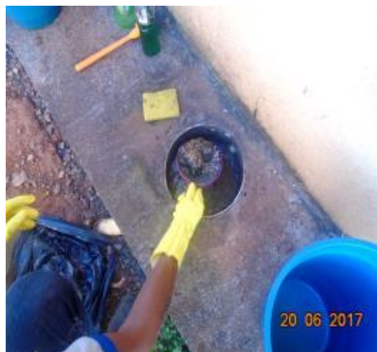
Figura 7.3-23 – Demonstração Supervisionada de Limpeza das Caixas de Gordura – RUC São Joaquim – 20/06/17
