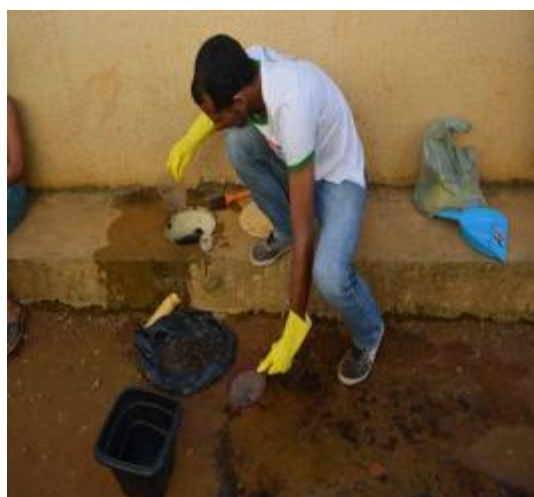
Figura 7.3-20 – Demonstração Supervisionada de Limpeza das Caixas de Gordura – RUC Jatobá – 19/05/17
