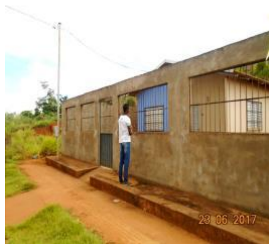
Figura 7.3-9 - Mobilização Porta a Porta para Demonstração Supervisionada da Limpeza das Caixas de Gorduras – RUC São Joaquim – 23/06/17
