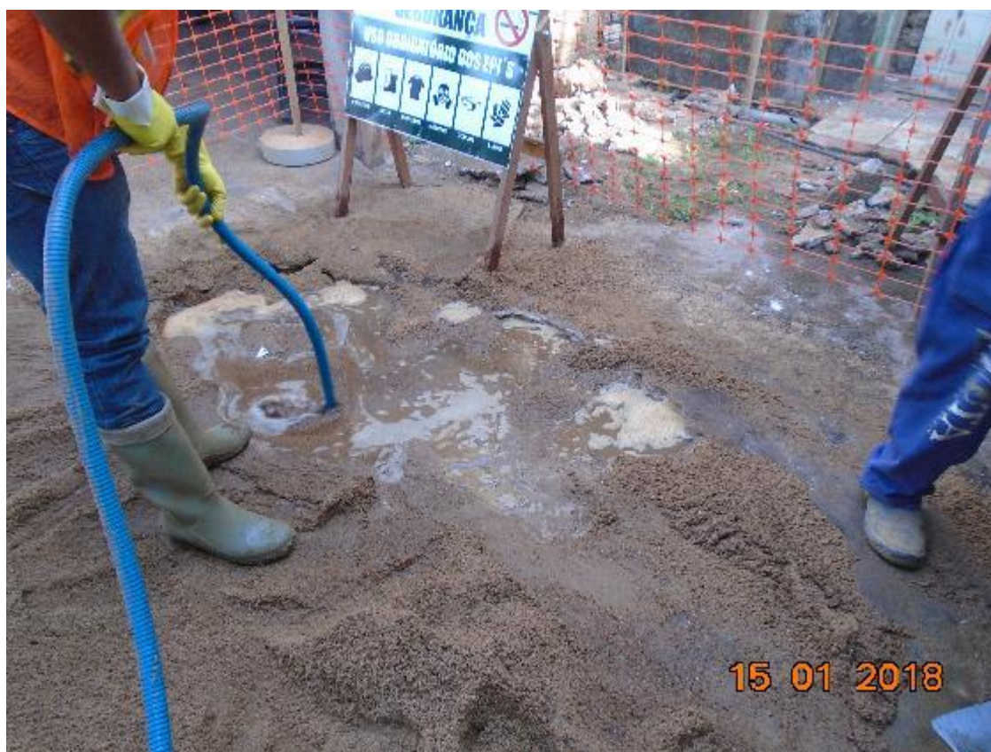
Figura 5.1.9 - 21 – Execução do encerramento de fossa/sumidouro
