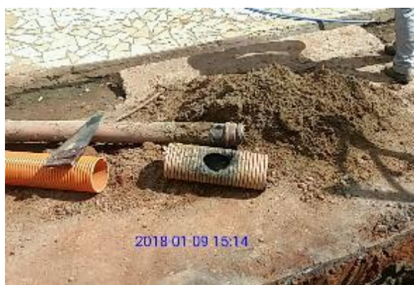
Figura 5.1.9 - 25 – Serviços de reparo e manutenção da rede
