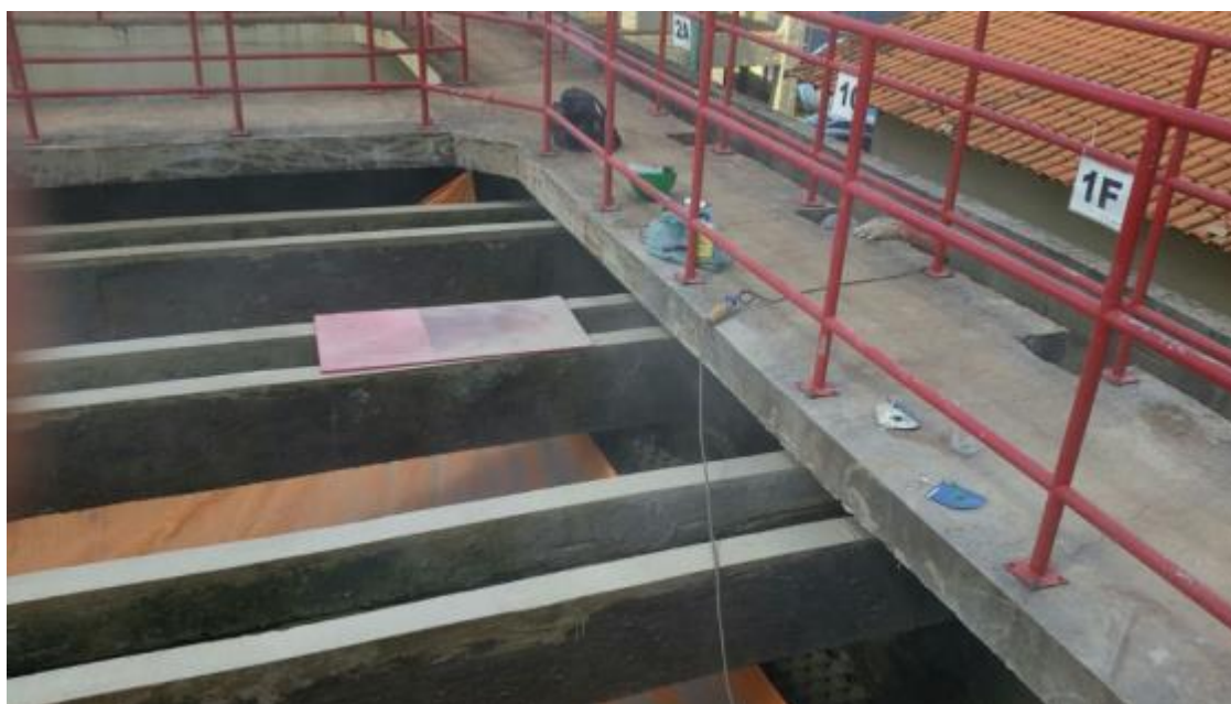
Figura 5.1.9 - 31 – Execução de melhorias nos flocladores
