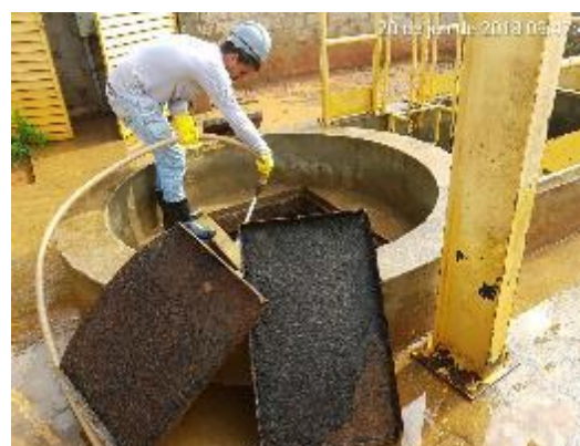
Figura 5.1.9 - 26 – Serviços de manutenção em unidades do sistema
