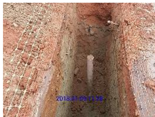
Figura 5.1.9 - 24 – Serviços de reparo e manutenção da rede
