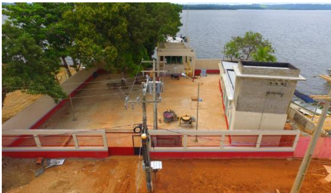
Figura 5.1.9 - 30 – Melhorias na estrutura administrativa da captação – vista aérea
