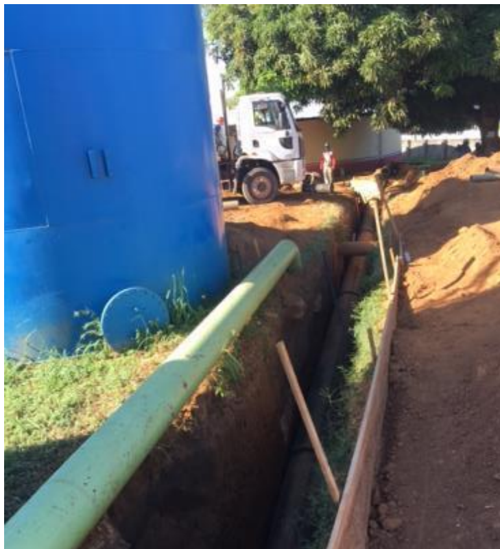
Figura 5.1.9 - 32 – Implantação adutora DN 500 (ampliação da adução)
