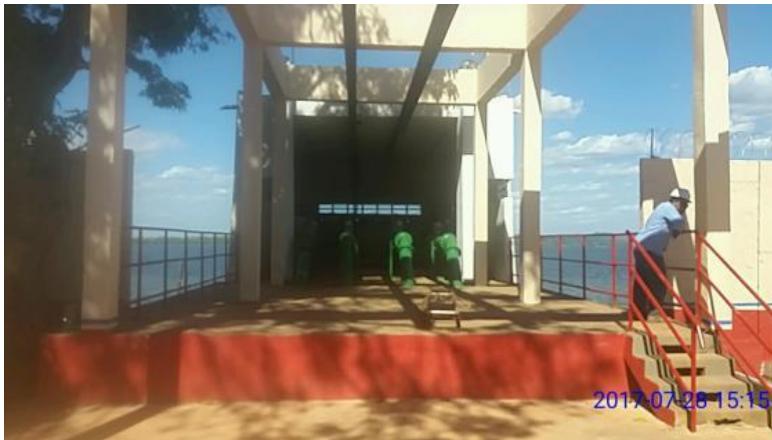
Figura 5.1.9 - 29 – Melhorias na estrutura administrativa da captação – elevatória da captação
