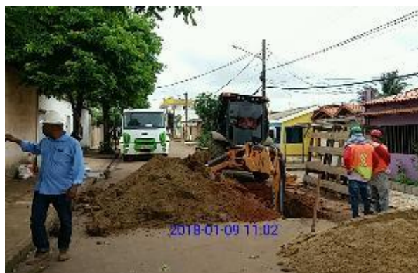
Figura 5.1.9 - 23 – Serviços de reparo e manutenção da rede
