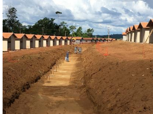
Figura 5.1.7-23- Implantação do muro de arrimo nas quadras
