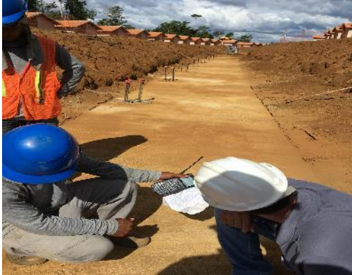
Figura 5.1.7-22- Implantação do muro de arrimo nas quadras
