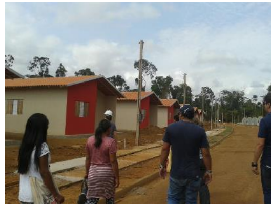
Figura 5.1.7-25- Visita ao canteiro de obras
