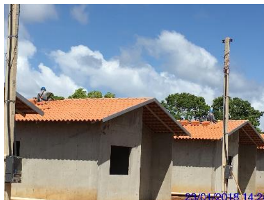
Figura 5.1.7-3- Aspecto construtivo das casa.
