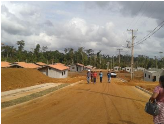
Figura 5.1.7-24- Visita ao canteiro de obras
