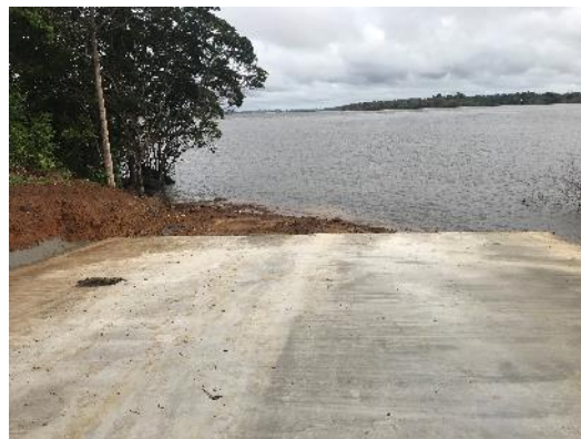
Figura 5.1.7-7- Rampa de acesso ao rio
