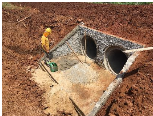
Figura 5.1.7-12- Obras de acesso ao RUC
