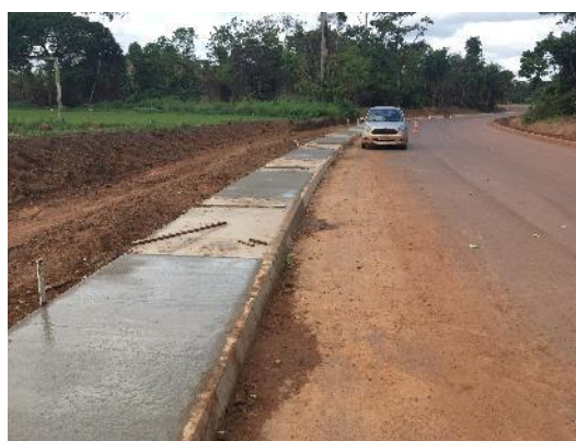
Figura 5.1.7-11- Obras de acesso ao RUC
