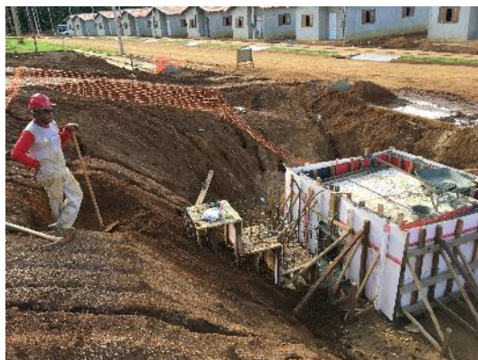
Figura 5.1.7-4- Infraestrutura do bairros
