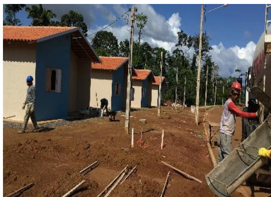
Figura 5.1.7-2- Aspecto construtivo das casa.
