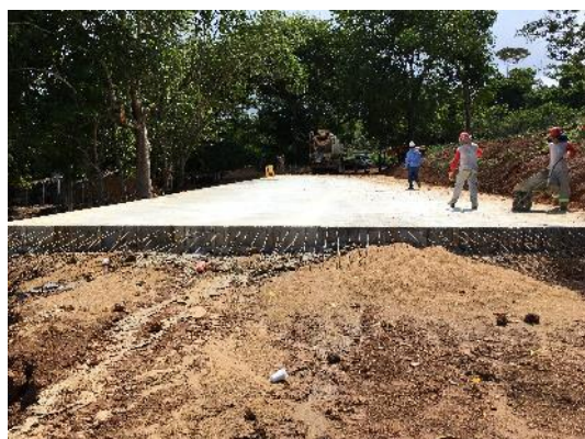
Figura 5.1.7-8- Rampa de acesso ao rio
