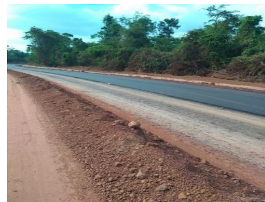
Figura 5.1.7-13- Obras de acesso ao RUC
