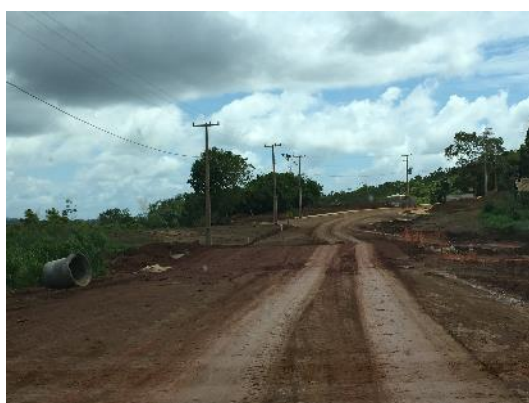
Figura 5.1.7-10- Obras de acesso ao RUC
