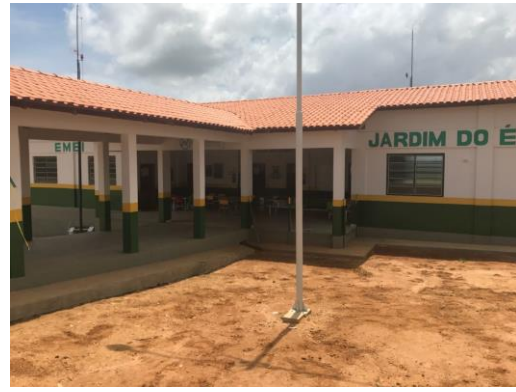
Figura 4.8.1-6 – Vista da obra da EMEI Jardim do Éden
