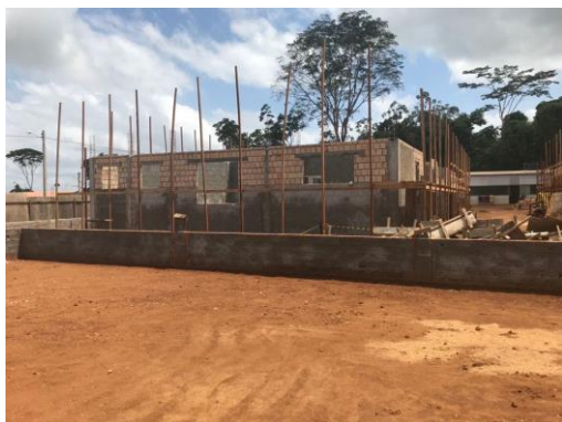
Figura 4.8.1-1 – Vista da obra da EMEIF do RUC Pedral
