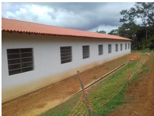
Figura 4.8.1-3 – Vista da obra da Escola do Pirarara
