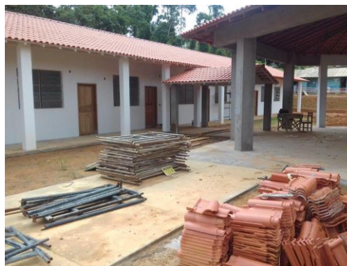
Figura 4.8.1-4 – Outra vista da obra da Escola do Pirarara
