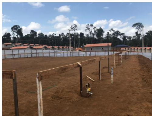
Figura 4.8.1-2 – Vista do início da obra da creche do RUC Pedral
