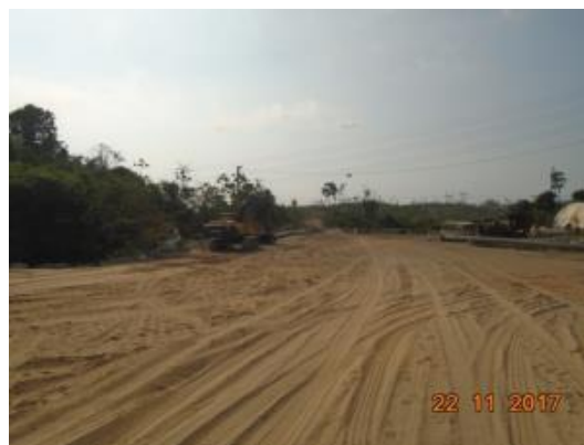
Figura 4.7.1-6 – Estrada de acesso à praia
