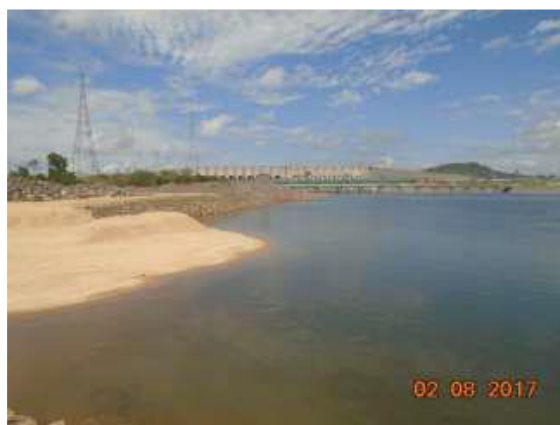
Figura 4.7.1-2 – Vista Geral do Canal de Fuga
