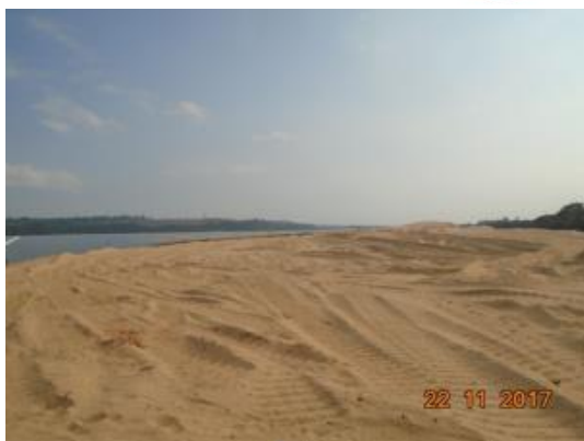
Figura 4.7.1-5 – Trabalhos de limpeza e regularização do terreno
