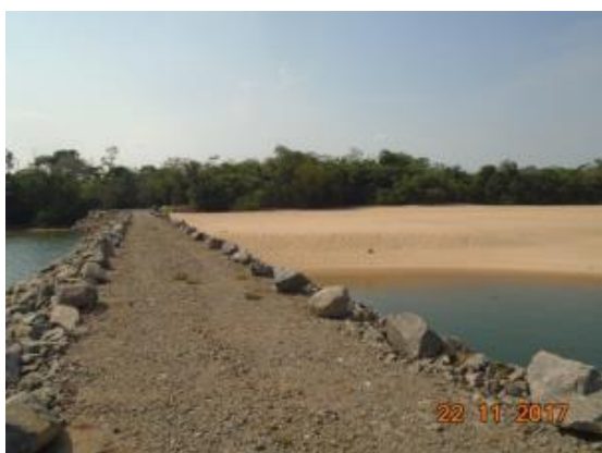
Figura 4.7.1-3 – Mole de contenção construído na praia
