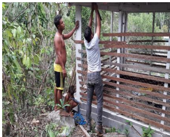
Figura 4.2.1 – 92 - Construção do aviário – Palhal – 17/10/2017
