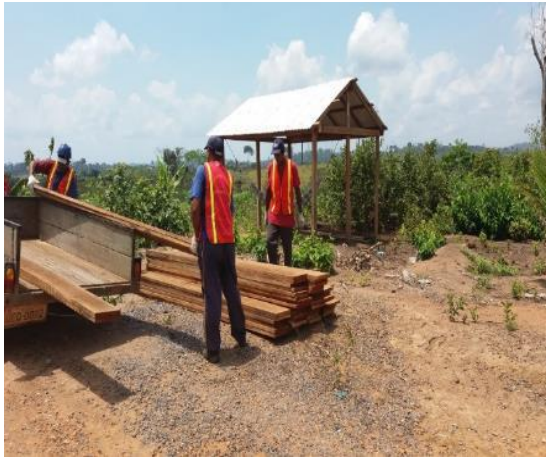
Figura 4.2.1 – 61 - Distribuição de Materiais Para a Construção do Galpão - 06/08/2017
