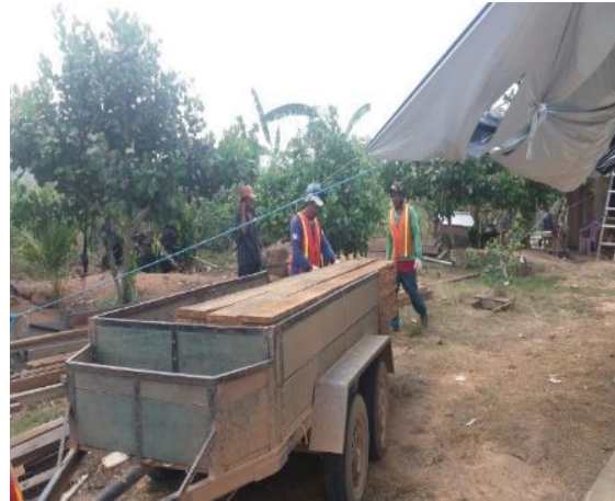
Figura 4.2.1 – 62 - Distribuição de Materiais Para a Construção do Galpão - 15/08/2017
