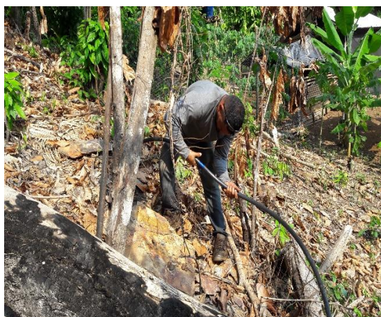
Figura 4.2.1 – 83 - Canalização da Nascente. 06/12/2017
