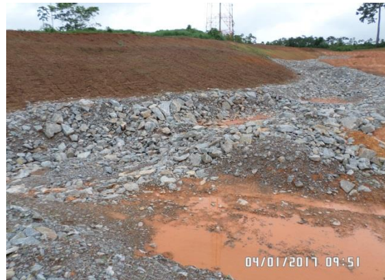
Figura 3.2 - 20 – Descida d'água na AE-3A – Sítio Pimental
