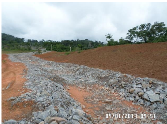
Figura 3.2 - 23 – Descida d’água reparada na AE-03 – Sítio Pimental
