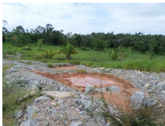
Figura 3.2 - 16 – Bacia de sedimentação na AE-1A – Sítio Pimental
