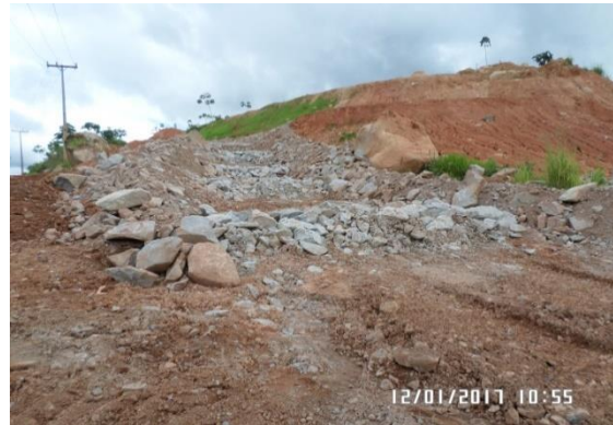
Figura 3.2 - 22 – Descida d'água enrocada na Pedreira ME – Sítio Pimental
