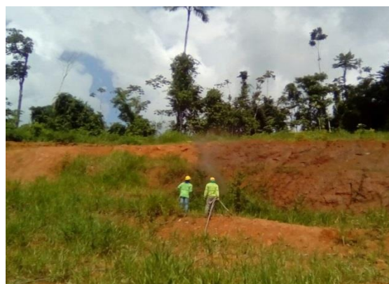
Figura 3.2 - 38 – Aplicação de hidrossemeadura – Sítio Belo Monte
