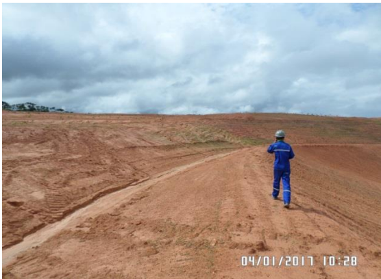
Figura 3.2 - 19 – Taludes conformados na AE-03 – Sítio Pimental
