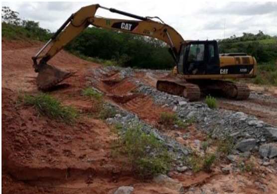
Figura 3.2 - 21 – Taludes conformados na AE-03 – Sítio Pimental
