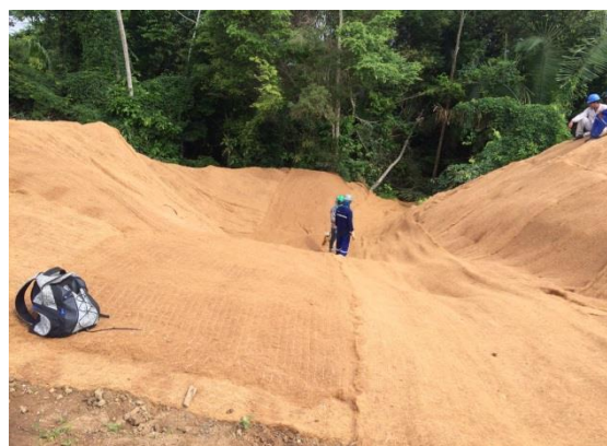
Figura 3.2 - 36 – Aplicação de fibromanta – Sítio Bela Vista
