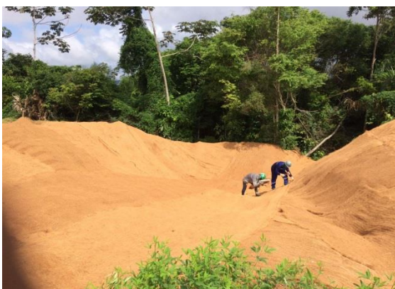
Figura 3.2 - 35 – Aplicação de fibromanta – Sítio Bela Vista
