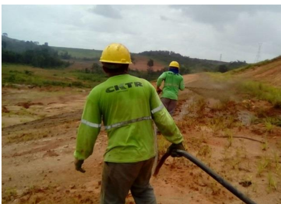
Figura 3.2 - 37 – Aplicação de hidrossemeadura – Sítio Belo Monte
