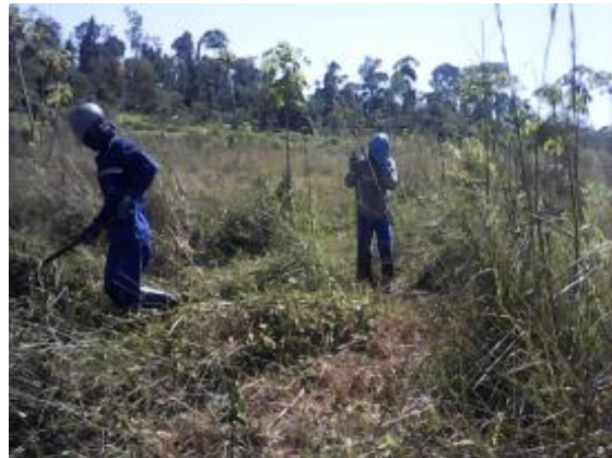
Figura 3.2 - 40 – Roçada e abertura de covas no Bota Fora 33 – Sítio Canais e Diques
