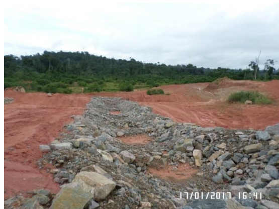
Figura 3.2 - 24 – Descida d’água reparada na AE-03A – Sítio Pimental
