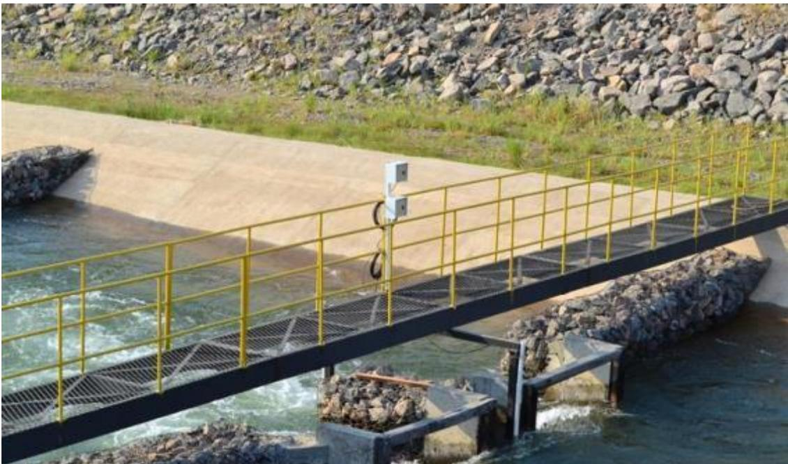
**Figura 13.3.6 - 33 – Sensores de profundidade do sistema de monitoramento hidráulico.**
