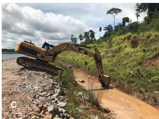
Figura 13.3.2 – 19 – Procedimentos de acompanhamento das atividades e resgate de peixes durante a limpeza do canal coletor de água dos igarapés interceptados.
