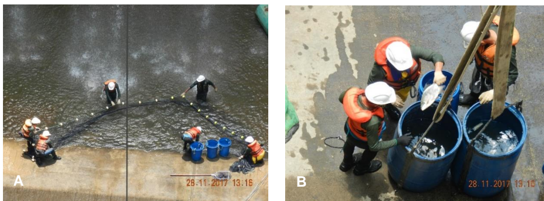
Figura 13.3.2 – 15 – Acompanhamento ambiental e resgate de peixes no vão 10 do vertedouro, Sítio Pimental. A – Utilização de rede de arrasto para atividades de resgate; B – Resgate e aclimação das espécies resgatadas para posterior identificação e soltura no reservatório do Xingu.
