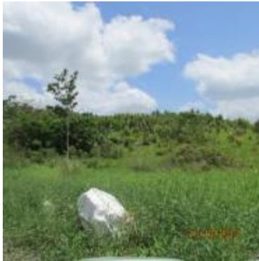
Inspeção Trimestral 7 (outubro/2013 - seca): Área estável.
