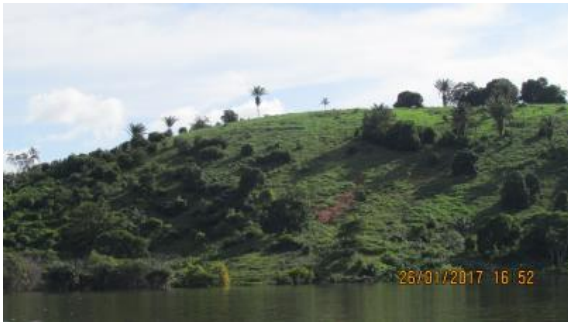
Inspeção trimestral 22 (janeiro/2017 - enchente): Blocos rochosos, na base e no leito do rio, submersos. Processo erosivo, causado por pisoteio do gado, aparentemente estável.
