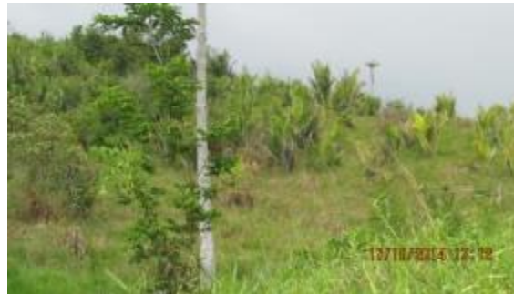
Inspeção Trimestral 11 (outubro/2014 - seca): Área estável.
