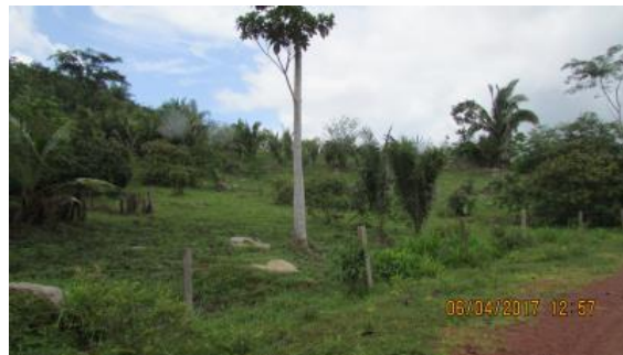
Inspeção trimestral 23 (abril/2017 - cheia): Sem alterações em relação a janeiro/2017. Aparentemente estável sob o ponto de vista geotécnico.
