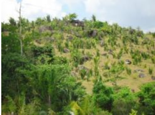
Inspeção Trimestral 1 (maio/2012 - cheia): Encosta vegetada, com matacões residuais de rocha cristalina.
