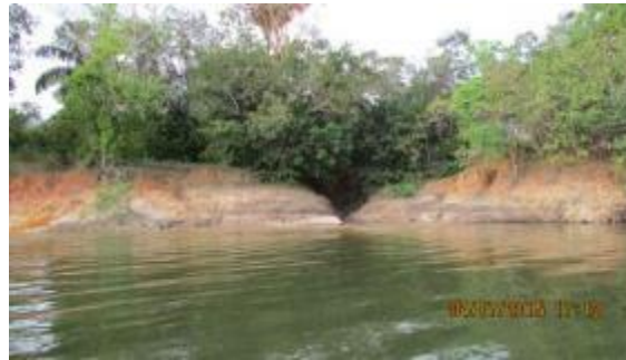
Inspeção Trimestral 14 (julho/2015 - vazante): Maior exposição do talude devido à diminuição do nível do rio. Foi instalado marco vertical (MV = 1 metro acima do solo).
