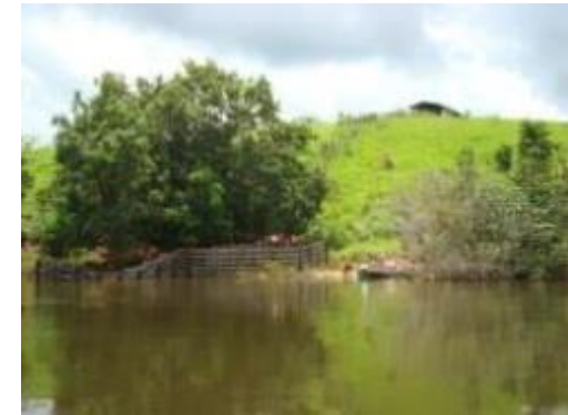
Inspeção Trimestral 9 (abril/2014 - cheia): Área aparentemente estável sob o ponto de vista geotécnico, observando-se ainda uma redução da exposição do talude, devido à elevação do nível do rio.
