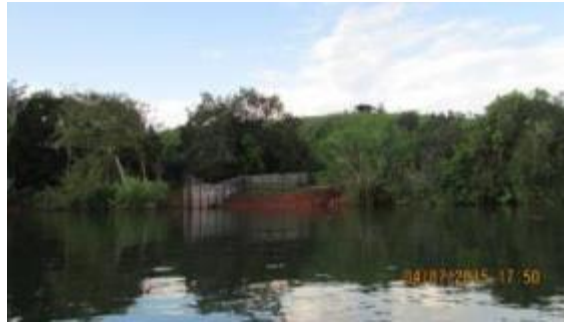
Inspeção Trimestral 14 (julho/2015 - vazante): Área aparentemente estável. Devido à diminuição do nível do rio, observa-se a exposição do talude, recoberto na vistoria anterior.
