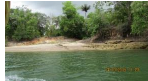
Inspeção Trimestral 15 (outubro/2015 - seca): Maior exposição do talude e da zona de praia devido ao rebaixamento da lâmina de água. Marco vertical foi retirado do local.
