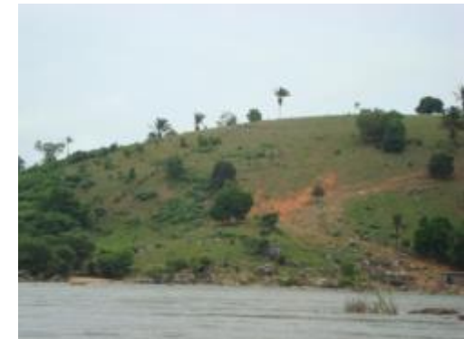
Inspeção Trimestral 12 (janeiro/2015 - enchente): Área potencialmente estável. Nota-se aumento da vegetação na encosta e menor exposição das rochas próximas à margem, devido ao aumento do nível do rio Xingu. Pouca diferenciação de características em relação às visitas anteriores em épocas similares.
