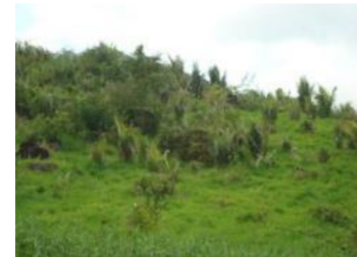
Inspeção Trimestral 6 (agosto/2013 - vazante): Apesar da presença de matacões, área estável.
