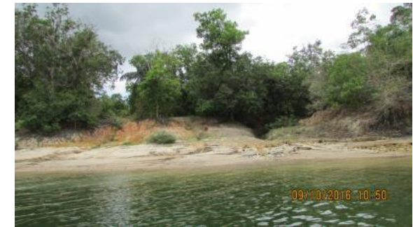
Inspeção trimestral 21 (outubro/2016 - seca): Talude e zona de praia erodidos pelo escoamento superficial derivado da microbacia a montante do rio. Foi observada maior quantidade de sedimentos carregados para o rio, fato devido às precipitações ocorridas. Processo ativo na continuação do canal a montante do rio, em função do escoamento superficial da microbacia de montante. Sem relação com a UHE Belo Monte.
