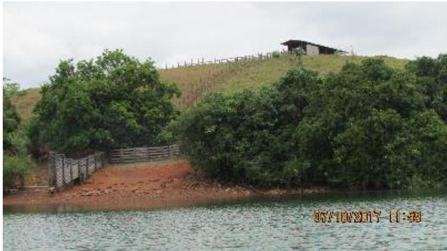
Inspeção trimestral 25 (outubro/2017 - seca): Zona de praia e talude mais expostos devido ao período de seca.
