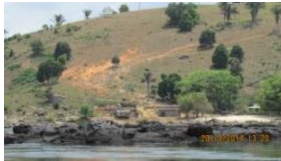
Inspeção Trimestral 11 (outubro/2014 - seca): Área potencialmente estável. Nota-se diminuição da vegetação na encosta e maior exposição das rochas próximas à margem, devido ao rebaixamento do nível do rio Xingu. Pouca diferenciação de características em relação às visitas anteriores em épocas similares.
