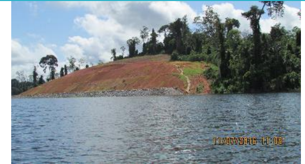
Inspeção trimestral 20 (julho/2016 - vazante): Região com quatro taludes com rampas em processo de revegetação. Em alguns pontos já se nota a presença de sulcos erosivos. Sem alteração em relação a abril/2016.
