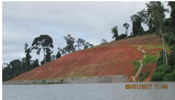
Inspeção trimestral 22 (janeiro/2017 - enchente): Taludes do canal de transposição CTCA (ponto coincidente com o ponto 32 do PBA 3.2) com parte da área submersa. Taludes com base enrocada, drenagem e início do processo de revegetação.
