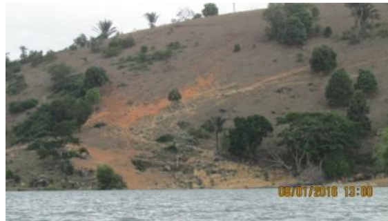
Inspeção trimestral 17 (janeiro/2016 - enchente): Blocos rochosos da base do talude totalmente submersos. Processo erosivo causado por pisoteio do gado, aparentemente estável.
