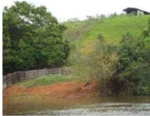
Inspeção Trimestral 8 (janeiro/2014 - enchente): Área aparentemente estável, mesmo com a elevação do nível do rio, notando-se apenas uma redução da exposição do talude.
