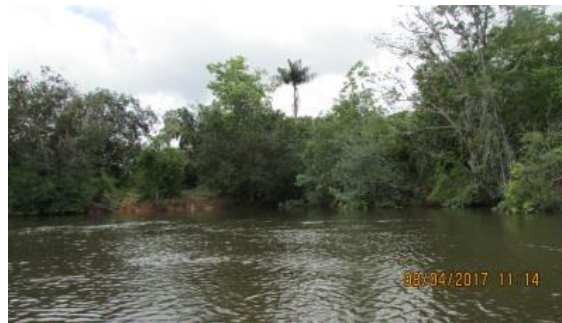
Inspeção trimestral 23 (abril/2017 - cheia): Talude parcialmente submerso e zona de praia totalmente submersa devido ao período de cheia. Na continuação do canal a montante do rio, o talude também está parcialmente submerso, em função do escoamento superficial da microbacia de montante. Sem relação com o empreendimento de Belo Monte.
