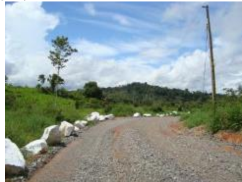
Inspeção Trimestral 5 (maio/2013 - cheia): Área estável; a via de acesso ao local foi revestida com brita, melhorando a capacidade de infiltração.
