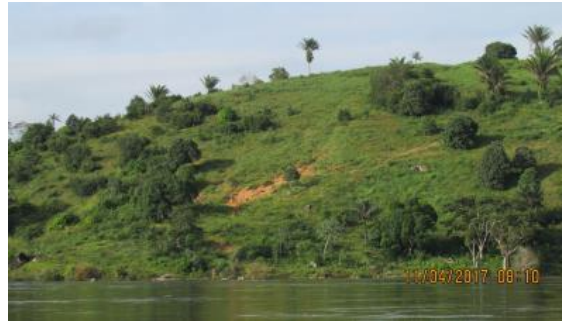
Inspeção trimestral 23 (abril/2017 - cheia): Sem alteração em relação a janeiro/2017. Aparentemente estável sob o ponto de vista geotécnico.
