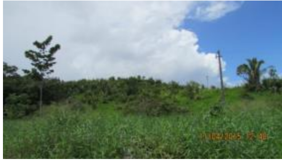
Inspeção Trimestral 13 (abril/2015 - cheia): Área estável.
