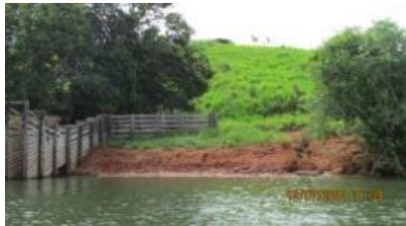
Inspeção Trimestral 10 (julho/2014 - vazante): Área aparentemente estável sob o ponto de vista geotécnico. Observa-se redução da exposição do talude devido ao rebaixamento do nível do rio Xingu em relação à vistoria anterior.
