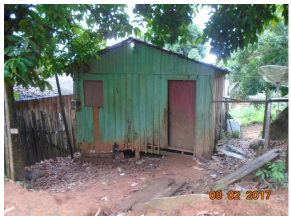
Figura - 6 – Domicílio com evidência de morador – Belo Monte do Pontal
