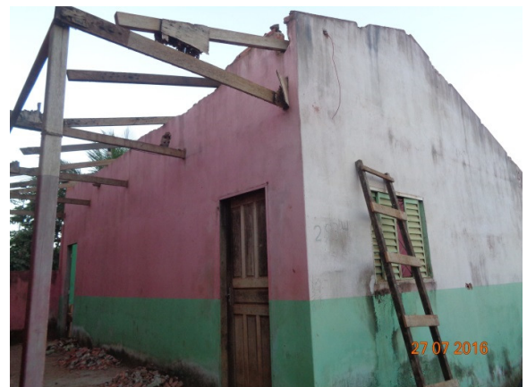
Figura - 6 – Domicílio em reforma - Bairro Mutirão – jul/16.
