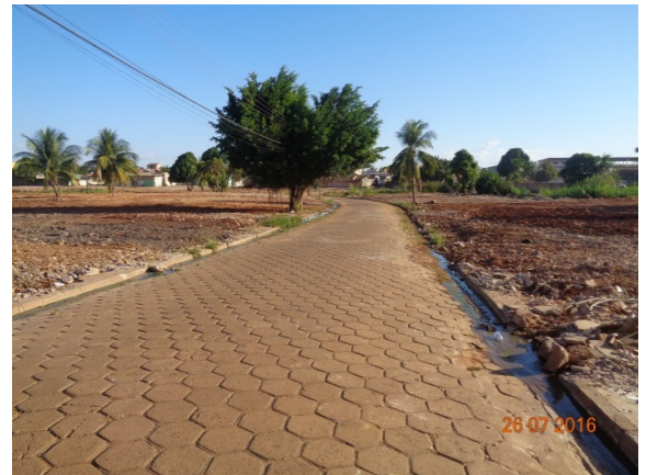
Figura - 4 – Domicílios Demolidos no Bairro Independe II – jul/16.
