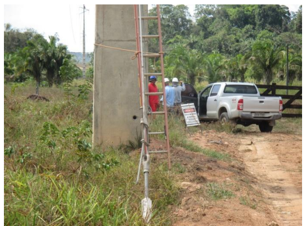
Foto 10- Inspeção amarração de escada.
