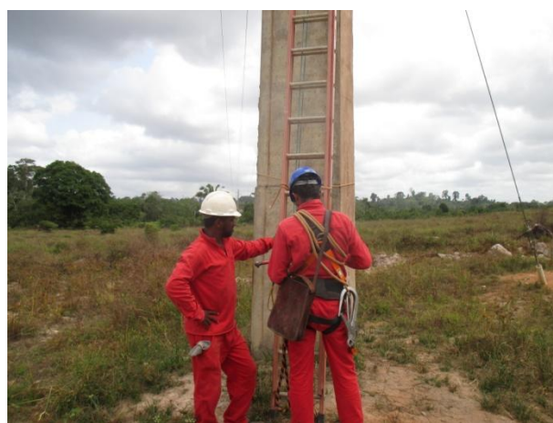
Foto 14- Check de equipamentos para trabalho em altura.
