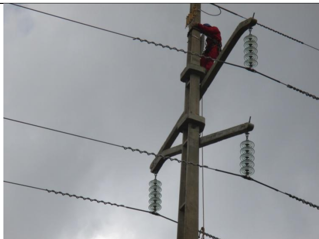
Foto 11- Inspeções trabalho em altura, uso de linha de vida.
