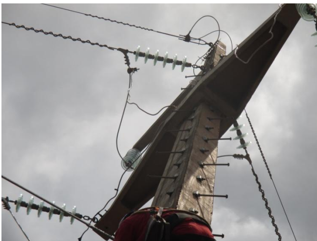
Foto 09- Inspeções uso de aterramento.
