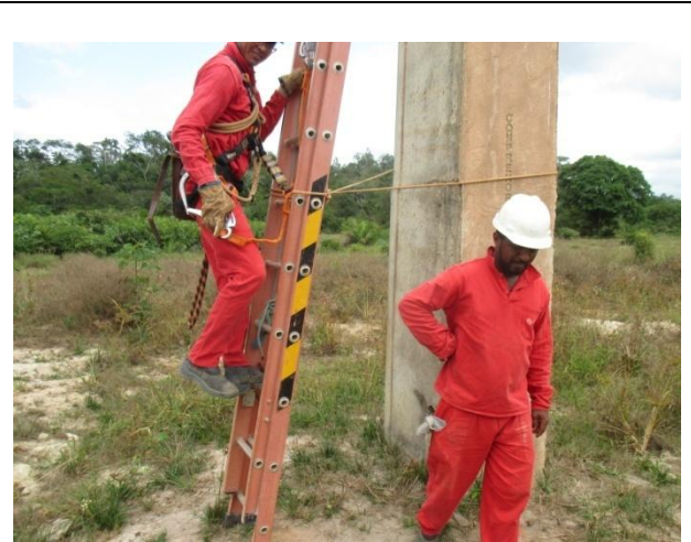
Foto 06- Inspeções trabalho em altura, amarração de escada de acesso.
