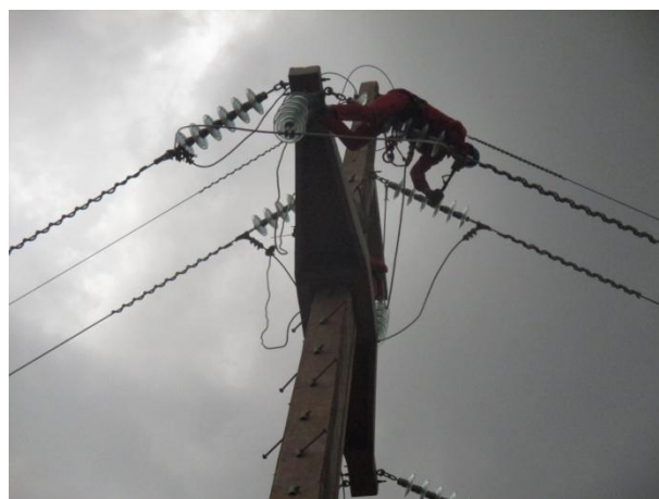
Foto 12- Inspeção aterramento temporario.
