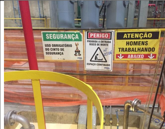
Figura 06 – Sinalização de segurança
