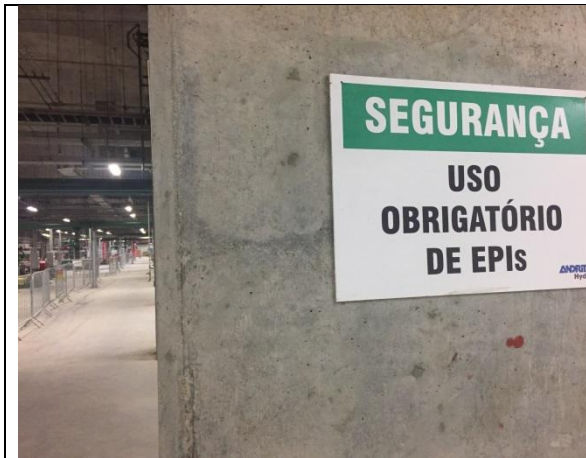
Figura 01 – Sinalização de segurança
