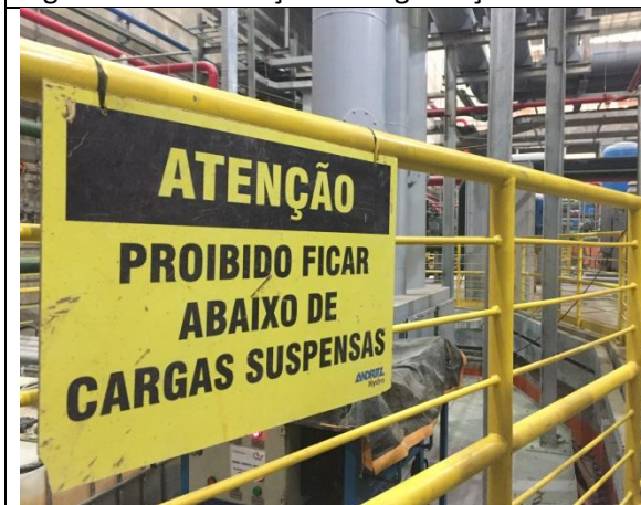
Figura 05 – Sinalização de segurança
