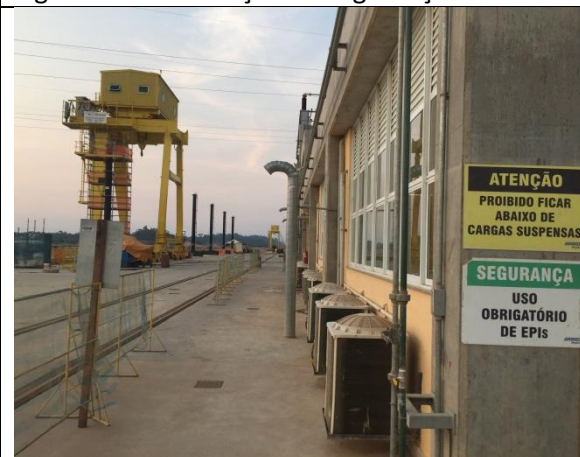
Figura 06 – Sinalização de segurança
