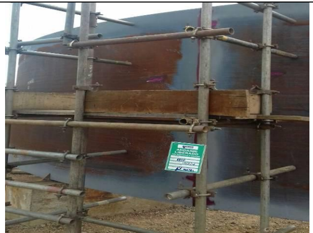
Figura 12: Sinalização de Segurança
