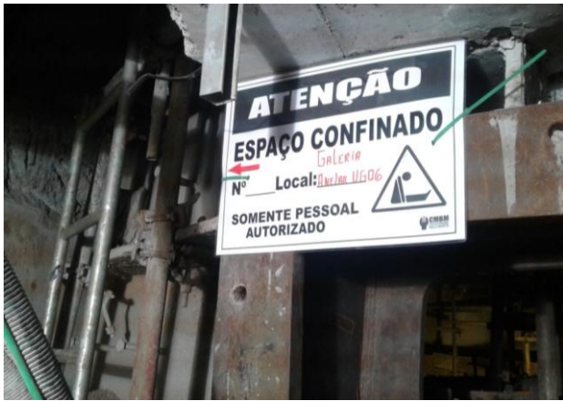
Figura 7: Sinalização de Segurança
