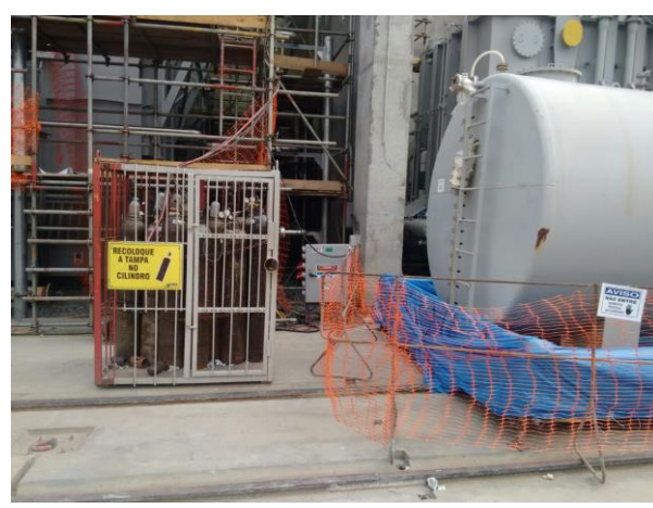
Figura 4: Sinalização de Segurança
