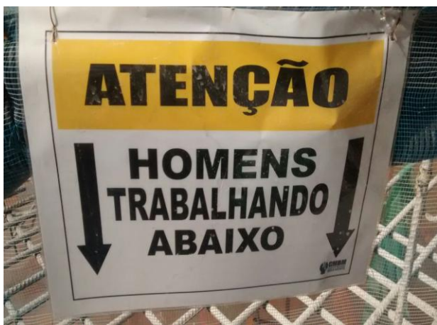
Figura 1: Sinalização de Segurança
