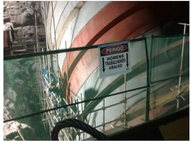
Figura 8: Sinalização de Segurança
