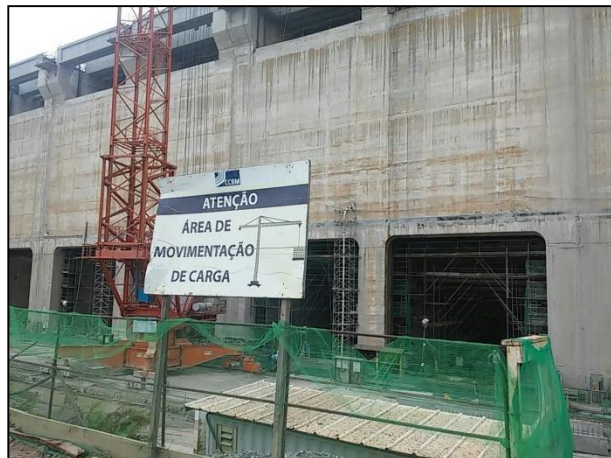
Anexo 3.4.2 – 1 – Sinalização de segurança nos Setores da obra.
