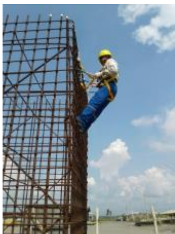
Figura 05 - NR 35 - Trabalho em Altura – CCBM.
