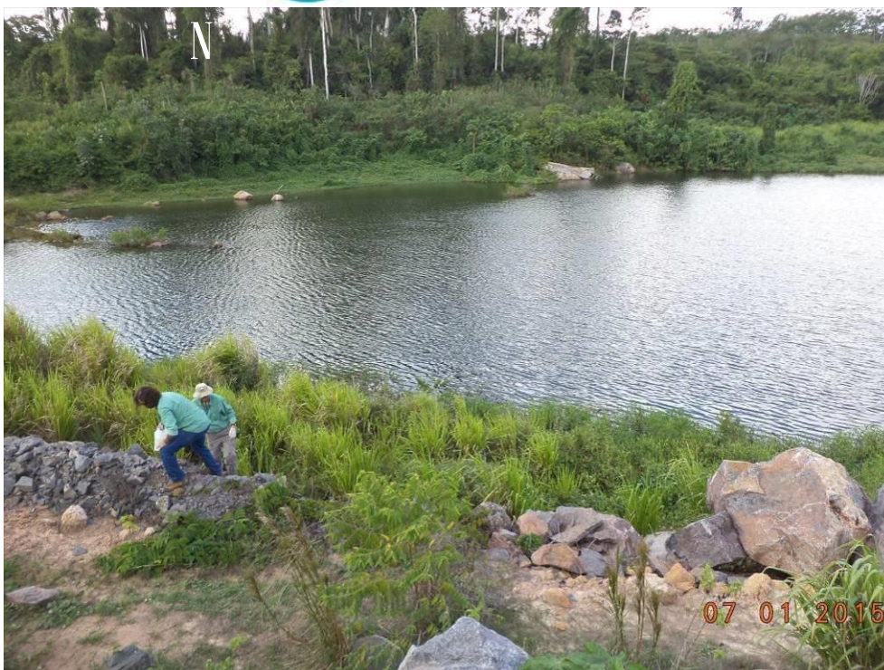
Foto - 1 – Vista da área de lançamento de efluentes no igarapé Paquiçamba (Sistema Ticaruca) no canteiro Canal e Diques em janeiro de 2015, correspondente ao período de enchente.
