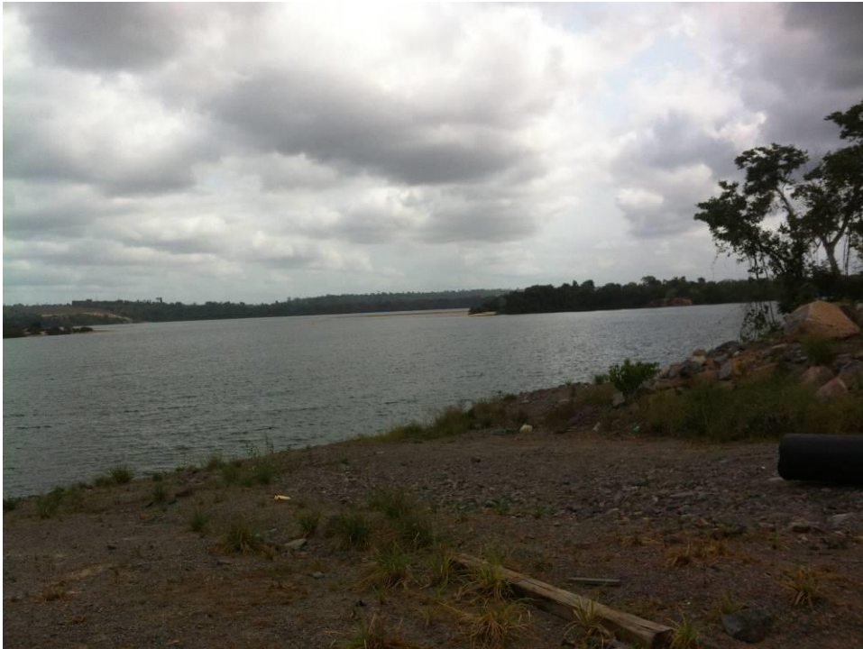
Foto - 3 – Vista geral do ponto de monitoramento localizado a montante da Vila Residencial em novembro de 2016.
