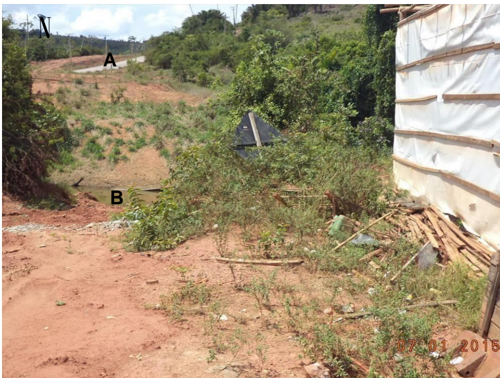
Foto - 2 – Detalhe da BR 230-Transamazônica (A) e vista da oficina mecânica construída adjacente ao igarapé Santa Helena (B), referida acima.
