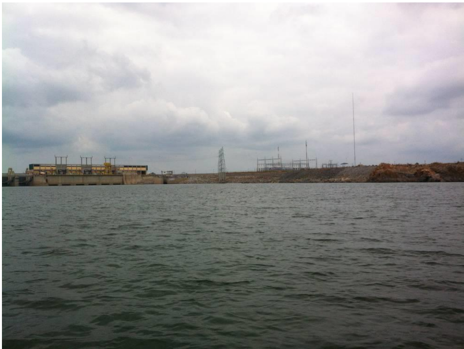
Foto - 2 – Vista geral do ponto de monitoramento SEPIM em novembro de 2016.
