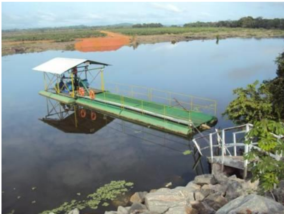
Foto - 2 – Ponto de captação de água bruta do canteiro Pimental PACPIM - M em 04/02/2015.
