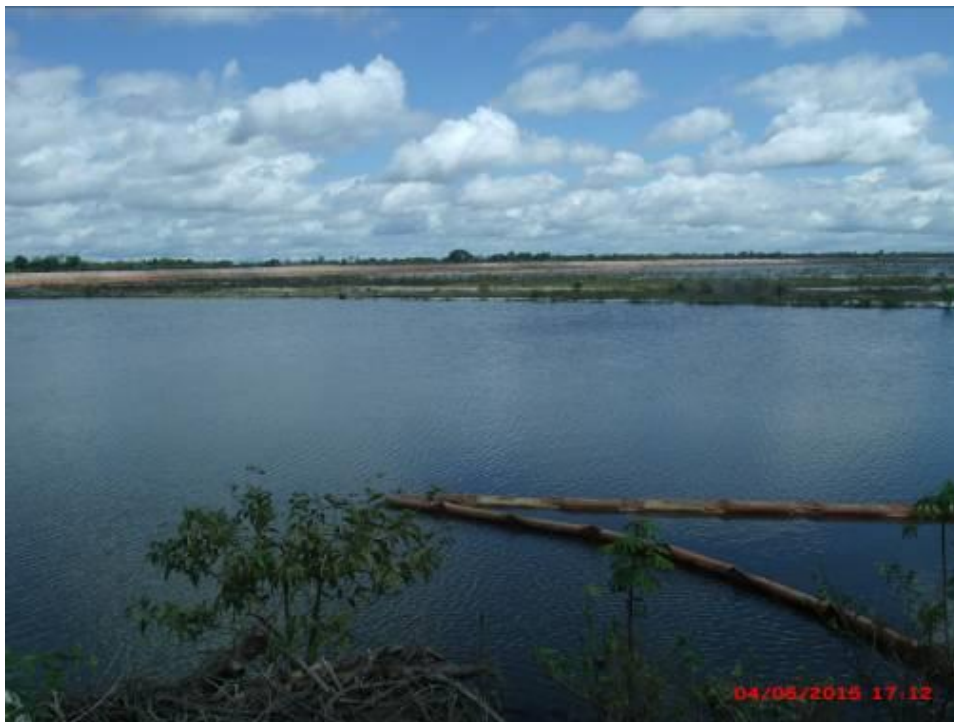
Foto - 2 – Ponto ETEPIM – Local onde foram realizadas ações para preservação da qualidade da água pelo Consorcio Construtor e para controlar o crescimento de bancos de macrófitas aquáticas (maio de 2015).
