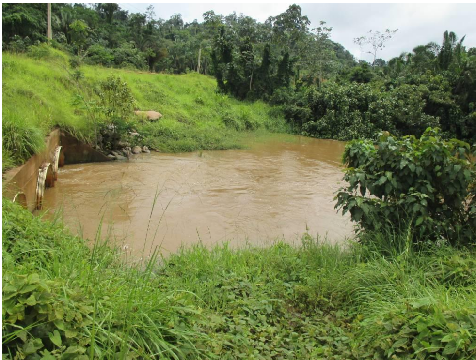
Figura - 66 – Registro fotográfico do ponto IGTIC em janeiro de 2017, localizado no igarapé Ticaruca, a jusante do dique 19B.
