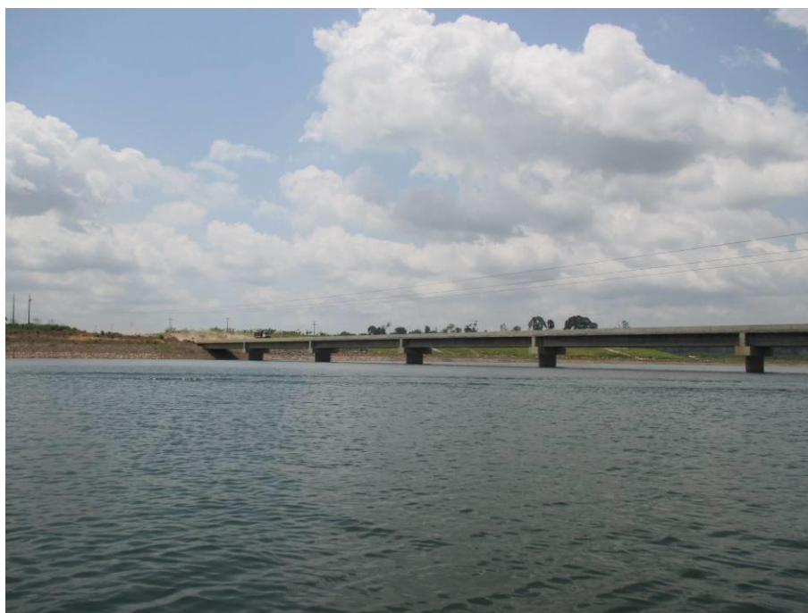
Figura - 71 – Registro fotográfico do ponto CANAL TRAV.27 em outubro de 2016, localizado no Canal de Derivação.
