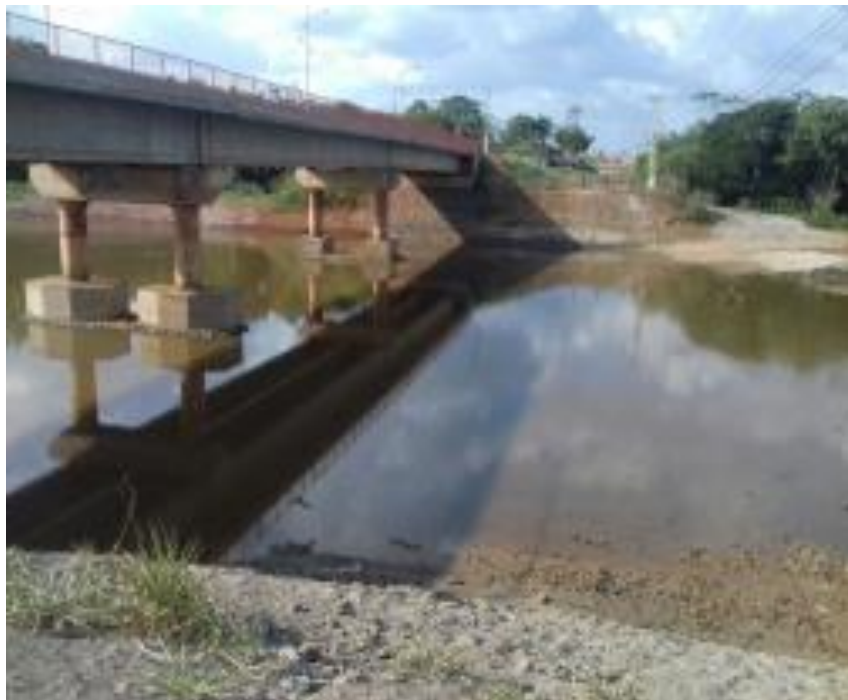
Figura - 6 – Registro fotográfico do ponto PAN02 em outubro de 2016, localizado no igarapé Panelas, na cidade de Altamira-PA.
