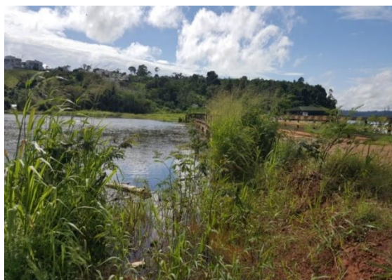
Figura 4 - Vista do aterro da Ponte da Rua da Peixaria (ponte ao fundo) - condição atual. Notar a proximidade do nível de água à cota do aterro
