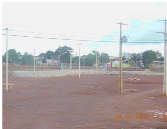
Figura 9 - Demais equipamentos de lazer em construção - Parque Igarapé Altamira
