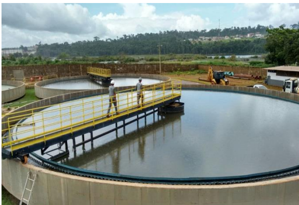
Figura 14 - Operação da ETE – Altamira – Tanques
