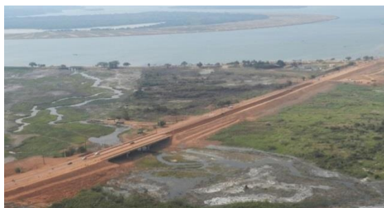
Figura 2 - Vista do Igarapé Ambé (calha do igarapé adequada) - Nova Ponte da Ernesto Acioly – Ponte da Rua da Peixaria ao fundo
