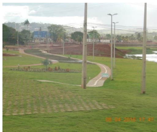
Figura 7 - Em andamento plantio de grama, concretagem de passeio e ciclovia - Parque Igarapé Altamira
