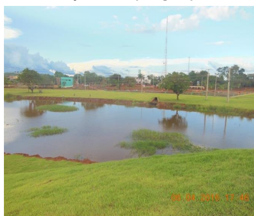
Figura 11 - Saída de drenagem - sistema viário e Parque Igarapé Altamira
