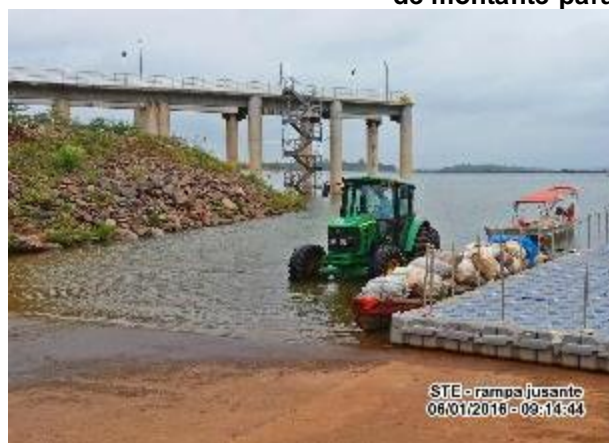
Figura 20 - Chegada de embarcação em dársena de jusante
