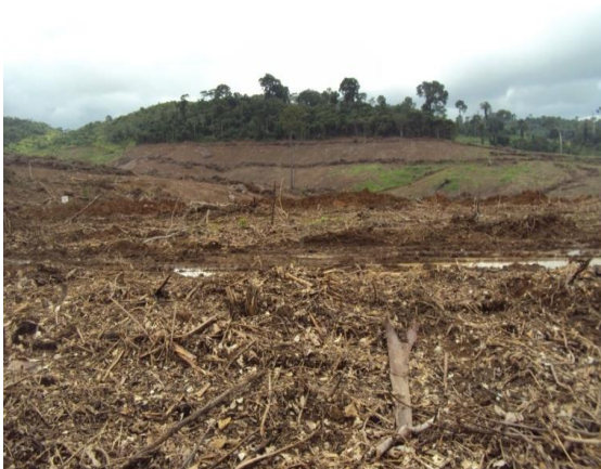
Figura 25 - Supressão vegetal realizada na região do Dique 19
