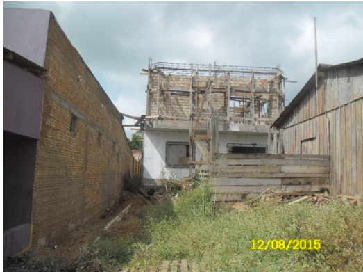
Figura - 1 – Domicílio em construção – Leonardo da Vinci – 7ª Campanha.
