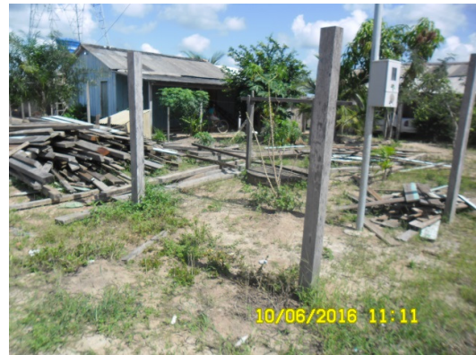
Figura - 10 – Domicílio Demolido – Vila Isabel – 8ª Campanha.
