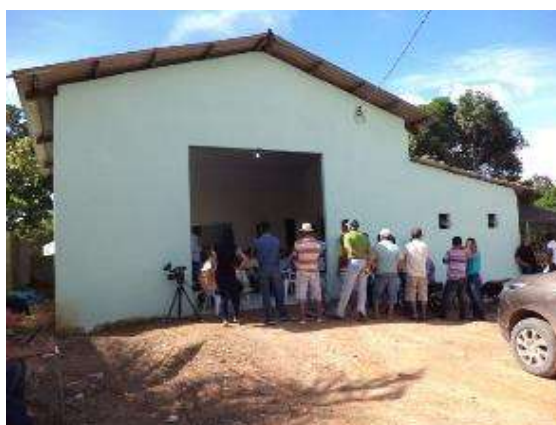
Figura 4.2.1 - 23 – Visão geral da estrutura da fábrica de polpa de frutas – Brasil Novo.
