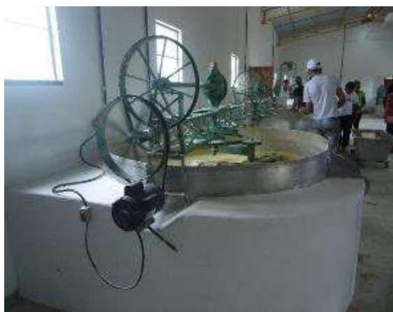
Figura 4.2.1 - 49 – Vista a área interna da Casa de Farinha - Vicinal 27
