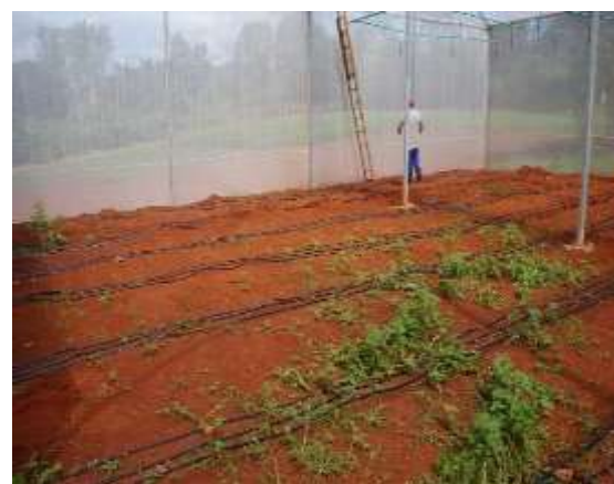
Figura 4.2.1 - 11 – Instalação de Estufa - Área Interna
