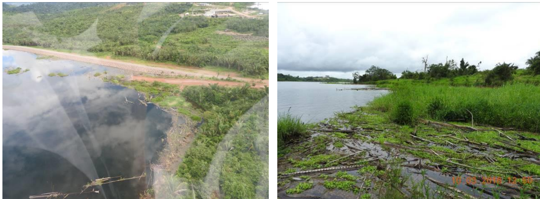
Figura – 51 – Registro fotográfico da ocorrência de infestação de macrófitas aquáticas no Ponto 09, localizado na bacia do igarapé Cajueiro em março de 2016. A esquerda: registro do sobrevoo de helicóptero; A direita: registro de campo que evidencia a ocorrência de plantas da família Poaceae (gramíneas) e da espécie Pistia stratiotes .
