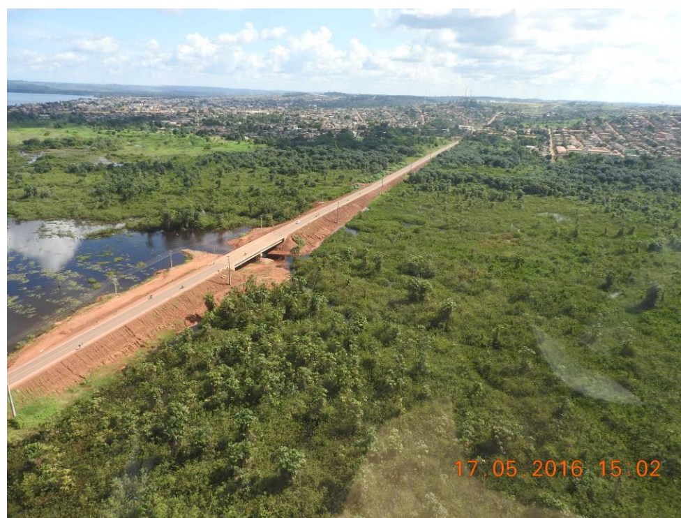
Figura - 18 – Área alagada na porção a montante do igarapé Ambé, junto ao cruzamento da ponte da Rodovia Transamazônica.
