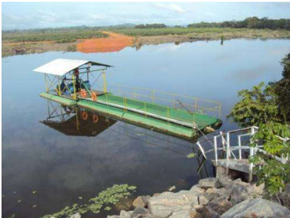
Foto - 2 – Ponto de captação de água bruta do canteiro Pimental PACPIM - M em 04/02/2015.
