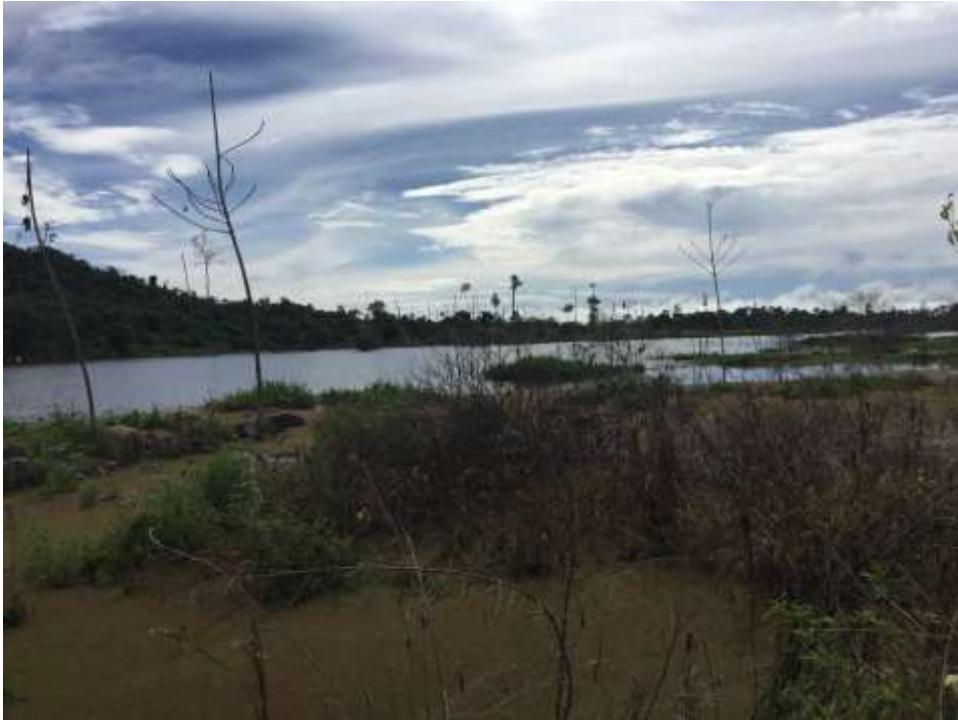
Foto - 3 – Vista da área de lançamento de efluentes no igarapé Paquiçamba (Sistema Ticaruca) no canteiro Canal e Diques em abril de 2016. Destaque para o crescimento de macrófitas na área.
