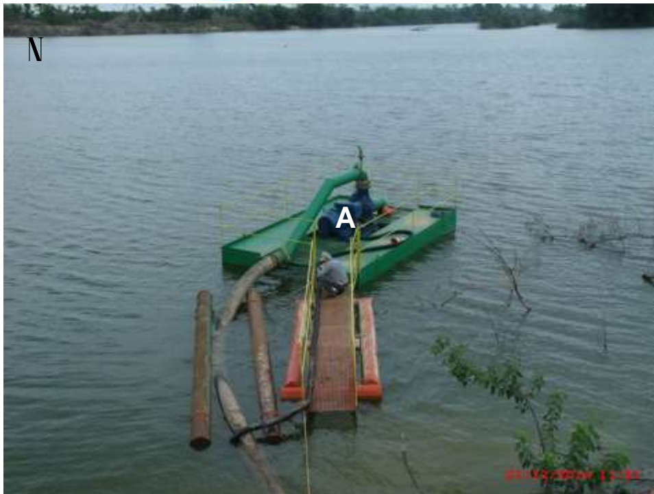
Foto - 1 – Ponto de captação de água bruta do canteiro Pimental, no rio Xingu. No centro a bomba de captação (A).
