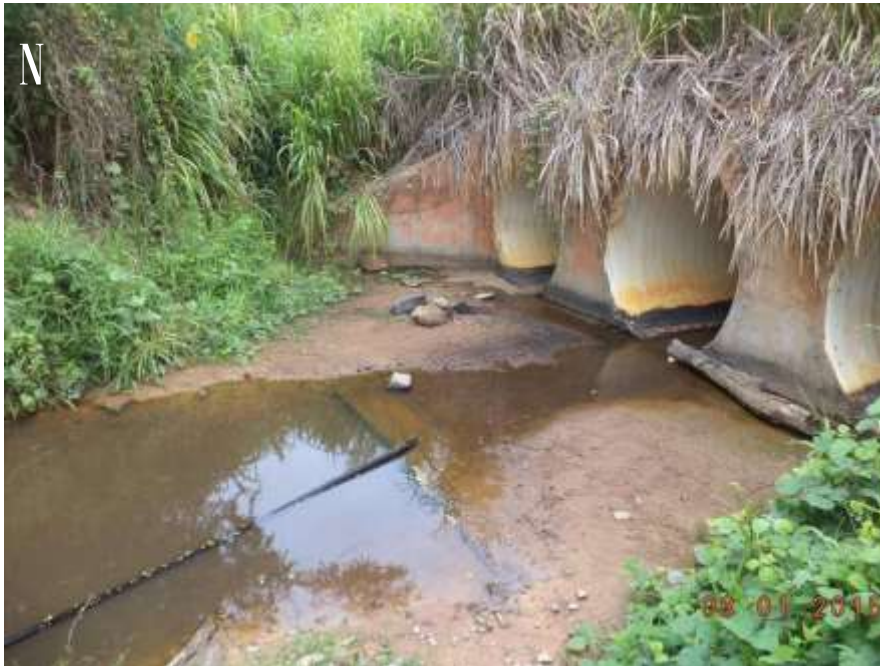
Foto - 1 – Vista do ponto de coleta limnológica no igarapé Paquiçamba a montante do Travessão km 27 e do canteiro Canal e Diques. Observa-se baixa vazão do igarapé devido a pouca precipitação na região na coleta de janeiro de 2015.
