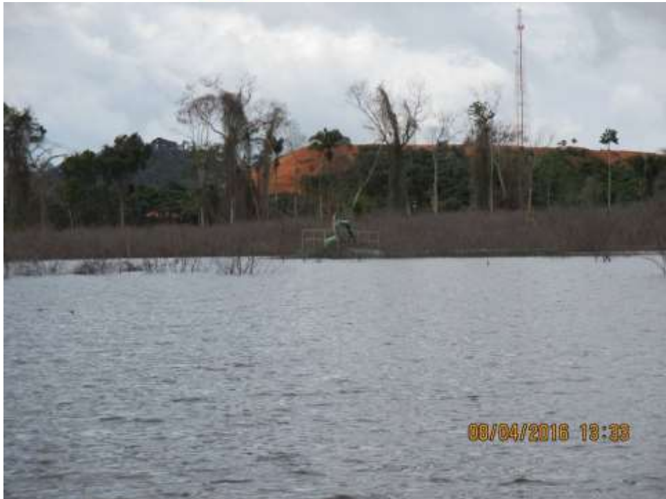
Foto - 5 – Vista geral do ponto de captação de água bruta para o sítio Pimental em abril de 2016.
