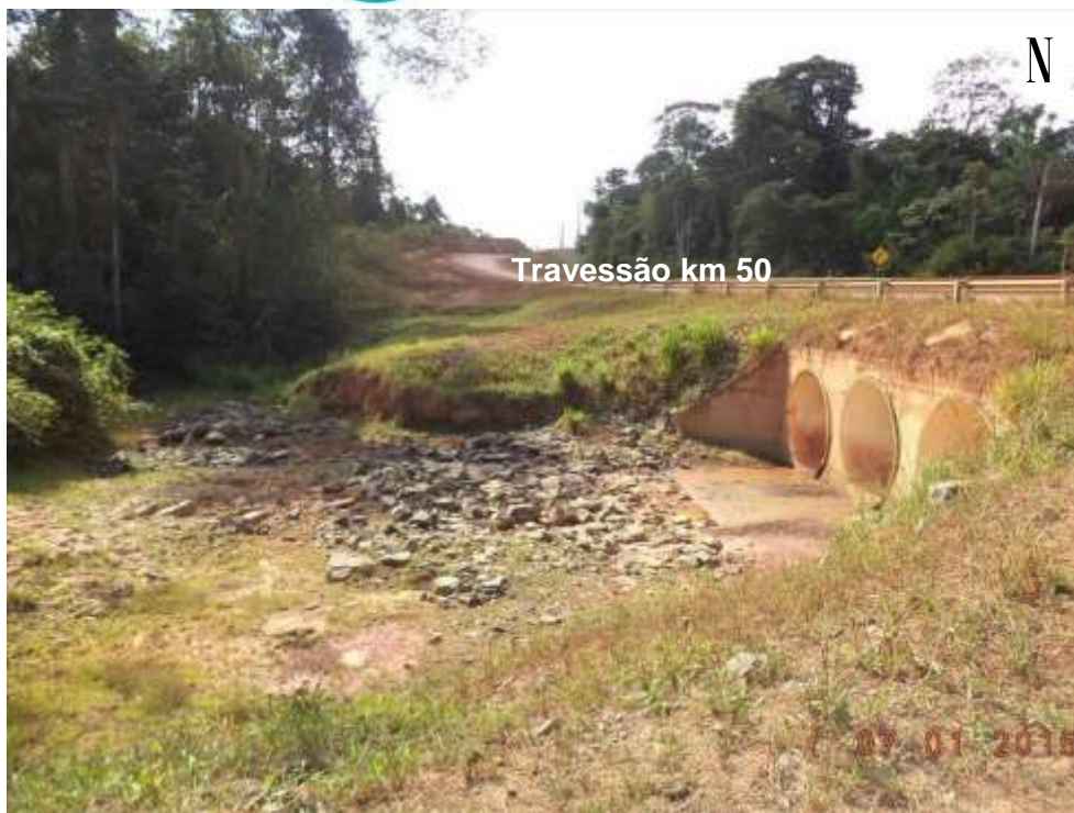
Foto - 1 – Vista do igarapé Santo Antônio no local de monitoramento. Observa-se que a reduzida vazão do igarapé impossibilitou a coleta em janeiro de 2015.
