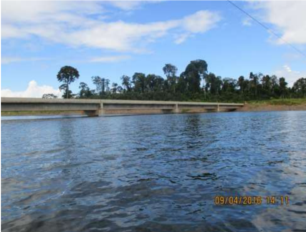
Figura - 71 – Registro fotográfico do ponto CANAL TRAV.27 em abril de 2016, localizado no Canal de Derivação.
