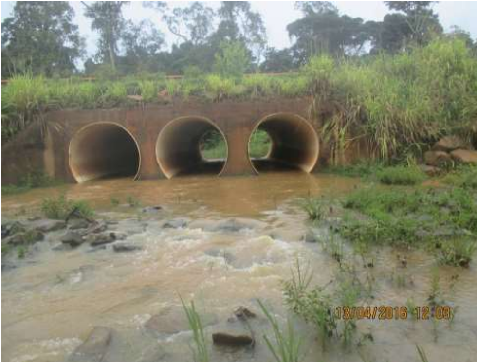
Figura - 56 – Registro fotográfico do ponto IGSA/SEBM em abril de 2016, localizado no igarapé Santo Antônio, próximo ao sítio Belo Monte.
