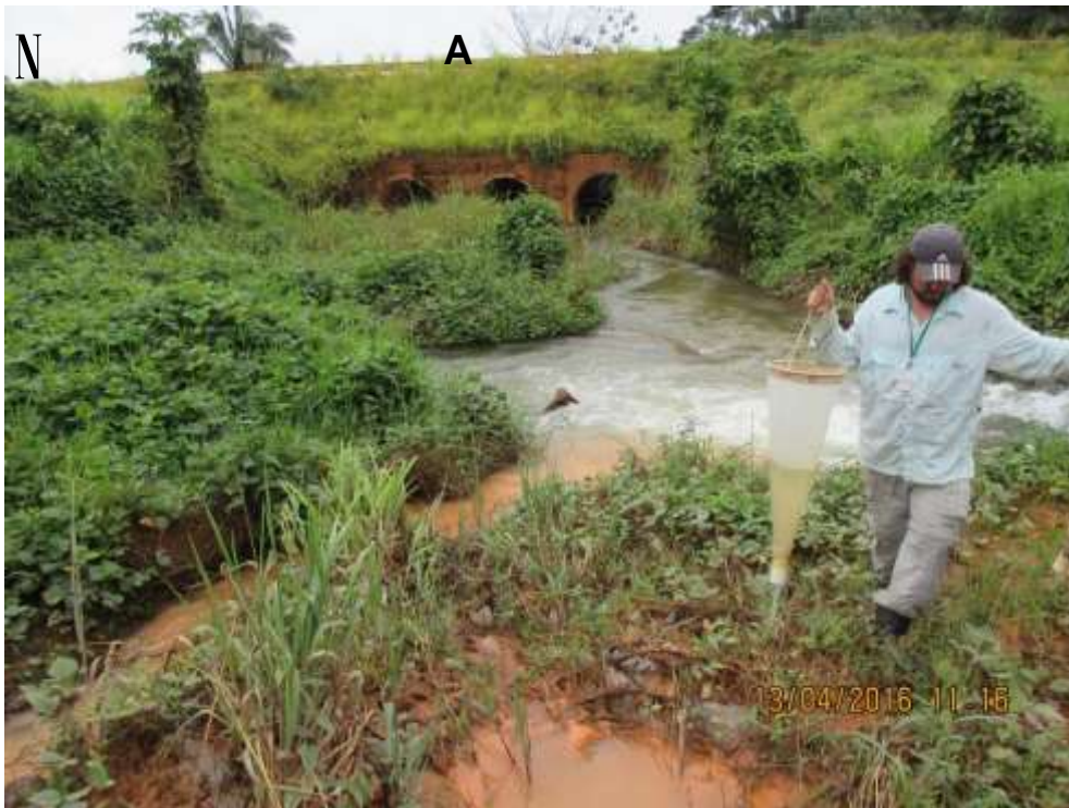
Foto - 5 – Vista do igarapé Cajueiro a jusante do dique 14C e do Travessão km 55 (A).
