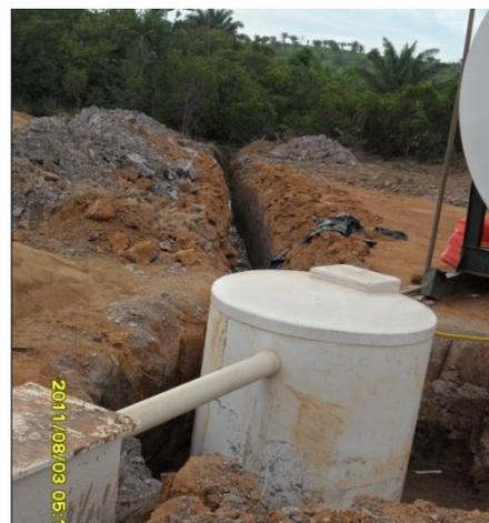
**Figura 3-14 e Figura 3-15** Modelo de ETE compacta que está sendo instalada nos canteiros pioneiros
