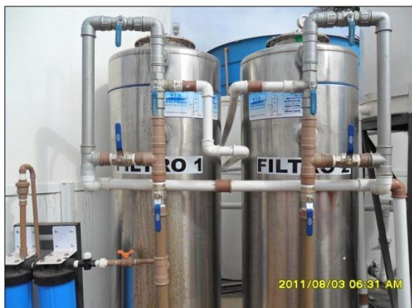
**Figura 3-11 e Figura 3-12** Modelo das ETA's que estão sendo instalados nos canteiros pioneiros
