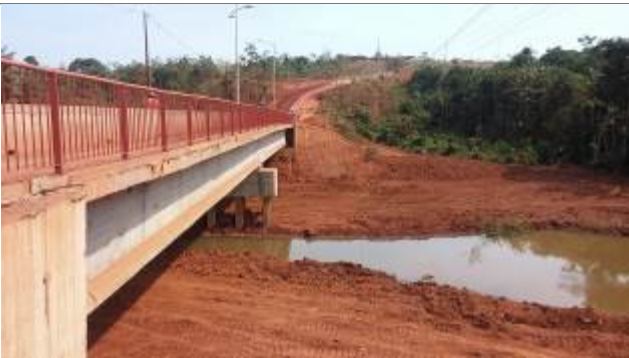
Foto 08: Ponte Rodovia Transamazônica (Altamira)
