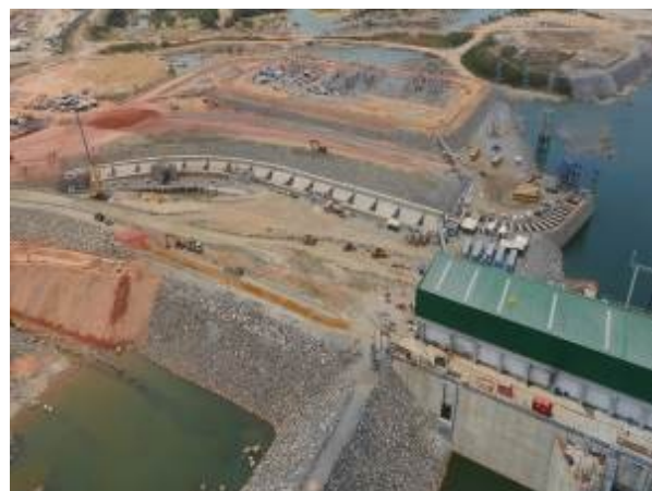
Fotos 03 e 04: Canal de derivação e vista do Sistema de Transposição de Peixes – Sítio Pimental
