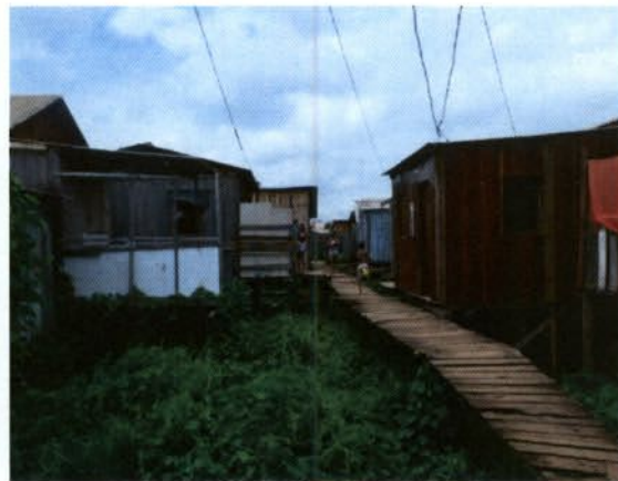
Foto 05 e 06 - Rampa e cruzamento de pontes, não segura com diversas tábuas soltas.
