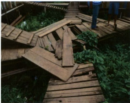
Foto 05 e 06 - Rampa e cruzamento de pontes, não segura com diversas tábuas soltas.
