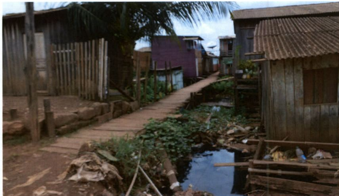
Foto 02 - Margem direita de entrada à área da Lagoa. Bairro Independente I Município de Altamira em 25/10/2016.
