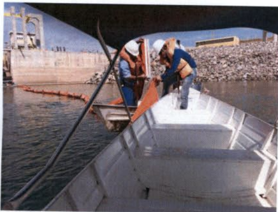
Figura 3 – Mobilização da barreira de contenção
