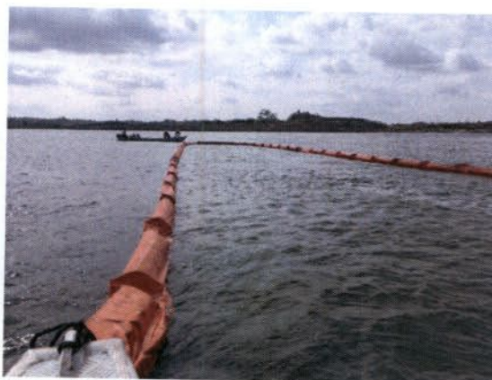
Figura 4 – Cercamento do óleo no corpo hídrico com a barreira de contenção
