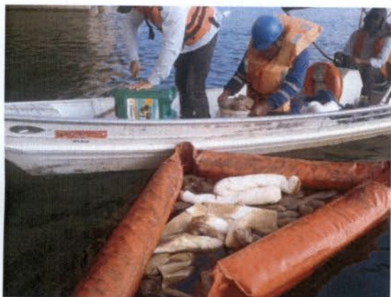
Figura 9 – Recolhimento das mantas e cordões absorventes
