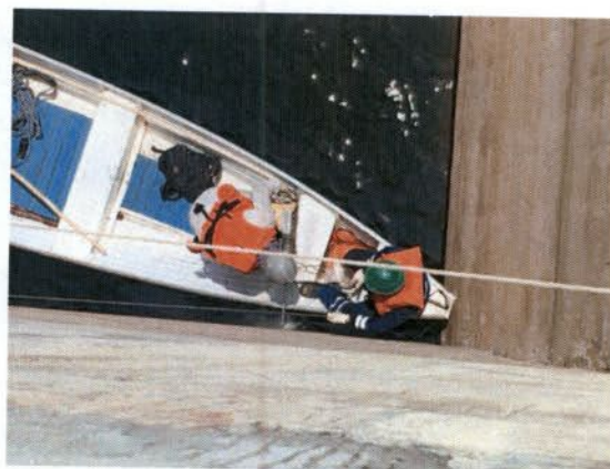
Figura 6 – Instalação de ponto de ancoragem no muro central
