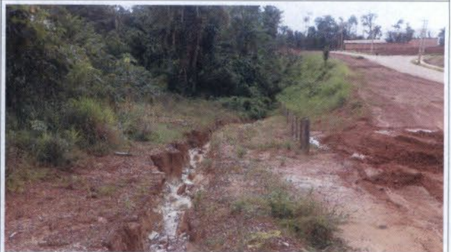
Foto 12 – Voçoroca formada no RUC Laranjeiras.
