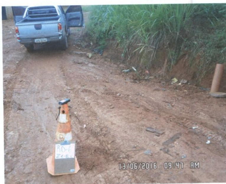
Figura 30: REGISTRO DE DESCARGA RD-6
