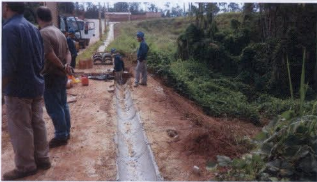
Foto 11 – Canaleta de drenagem de água pluvial sendo implantada no RUC Laranjeiras.
