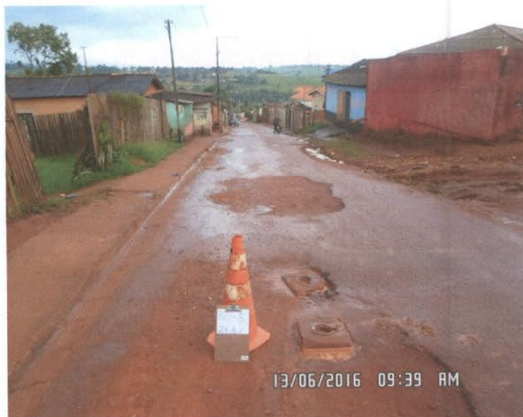
Figura 28: REGISTRO DE DESCARGA RD-05
