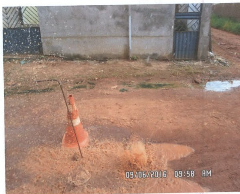
Figura 32: REGISTRO DE DESCARGA RD-15
