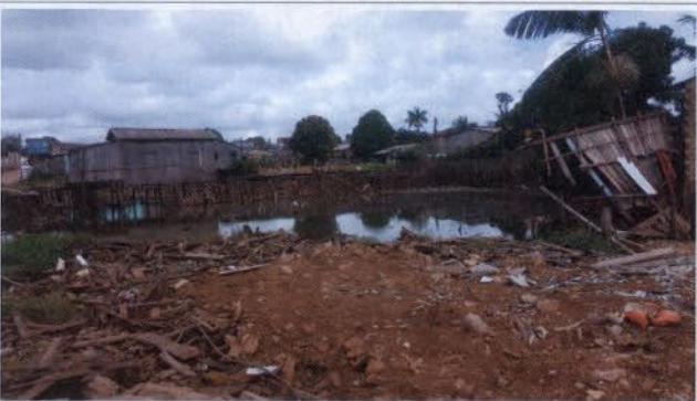
Foto 15 – Demolição de residências no Bairro Jardim Independente II.
