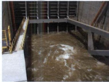
Foto 4 – Turbulência no vertedouro Pimental (parte interna).
