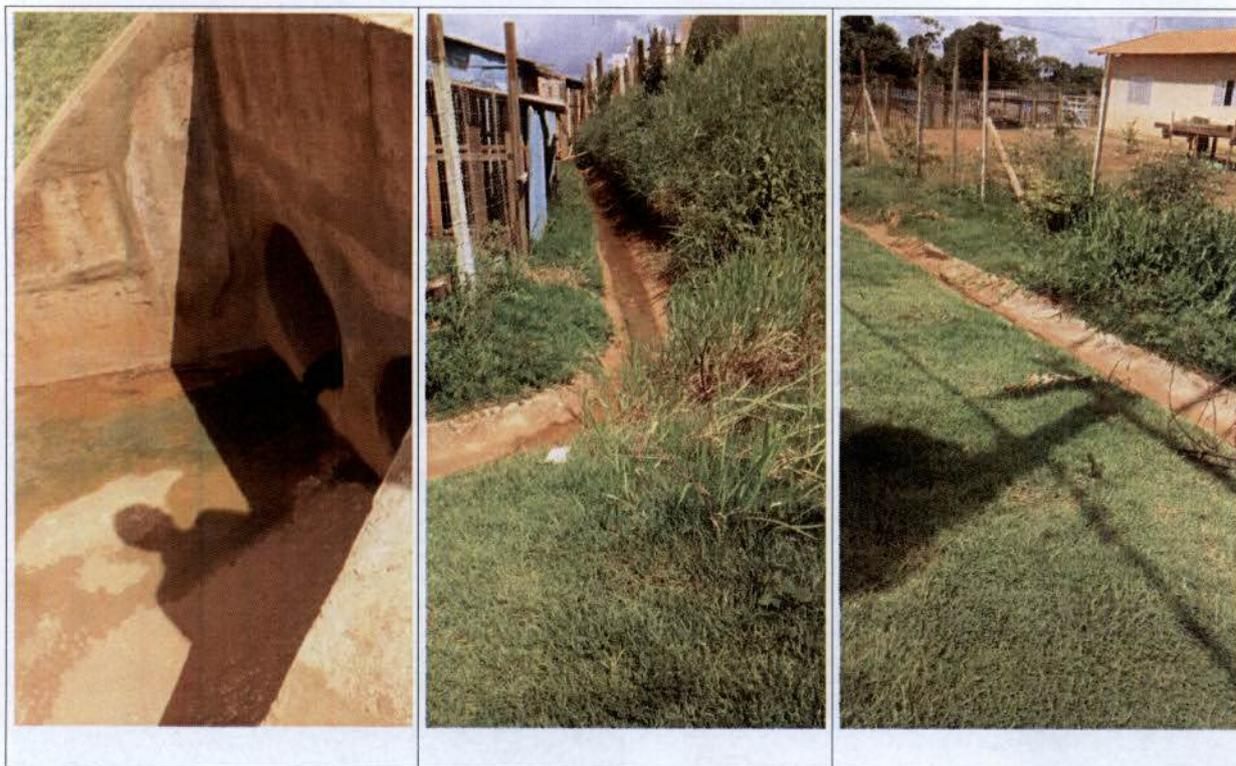
Percebe-se portanto que há dois problemas distintos relacionados à não segregação dos efluentes. Por um lado, percebe-se que há correlação entre o transbordamento de bueiros em dias de chuva, caracterizando que não há segregação desses efluentes dentro do sistema de coleta. Por outro lado, a própria população despeja atualmente efluentes sanitários dentro do sistema de drenagens.
