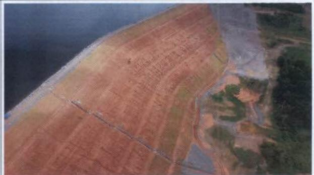
**Foto 14** – Talude de dique do reservatório Intermediário com presença significativa de sulcos e ravinas.
