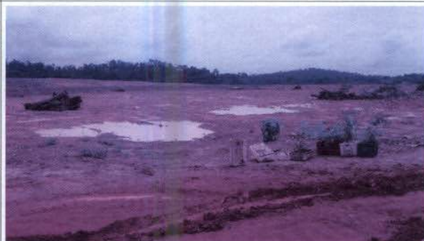
Foto 6: Replanteio em PRAD de bota-fora do Sítio Canal e Diques.
