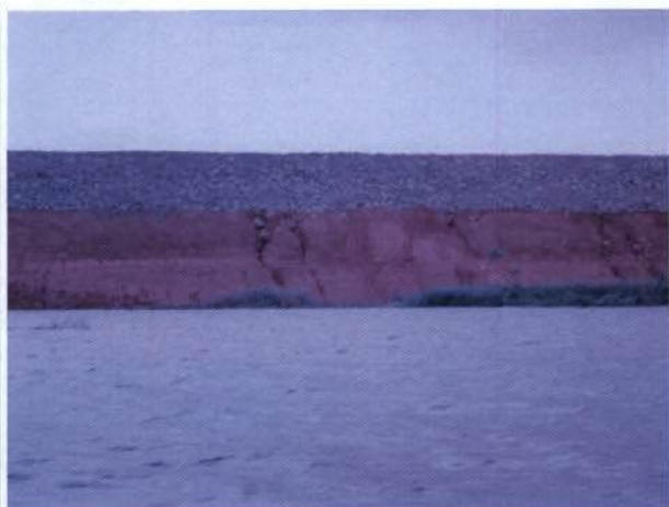
Foto 26: Dique com alguns processos erosivos.
