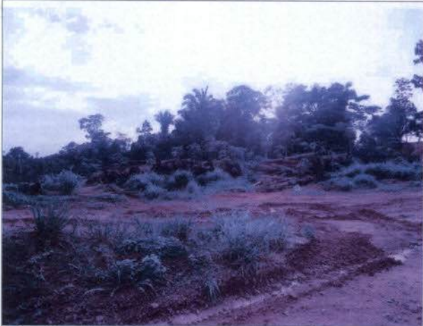
Foto 7: Pátio de armazenamento de madeira necessitando manutenção.
