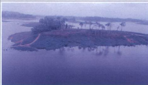
Foto 14: Futura ilha do Reservatório Intermediário.
