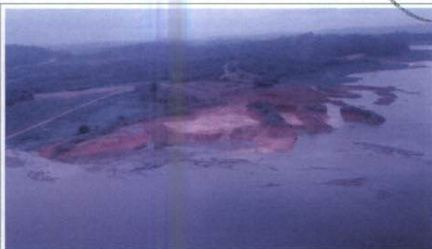
Foto 17: Área de empréstimo a ser submersa pelo Reservatório Intermediário.
