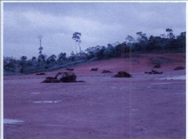
Foto 35: Prad em Bota fora onde os núcleos estão sendo feitos utilizando resíduos grossos.
