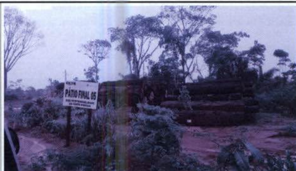
Foto 2: Pátio de armazenamento de madeira necessitando manutenção.
