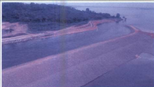
Foto 20: Canal lateral de enchimento do Canal de Derivação.
