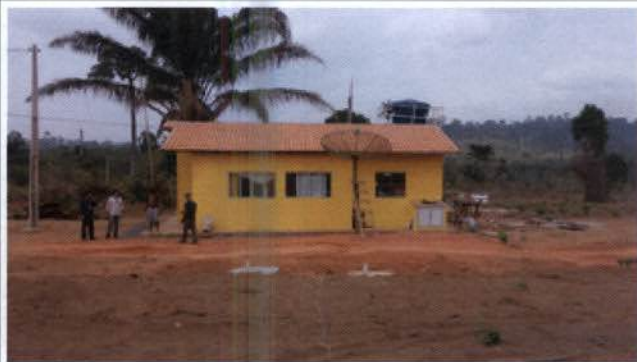
Foto 10 - Residência no RRC no Travessão 27.
