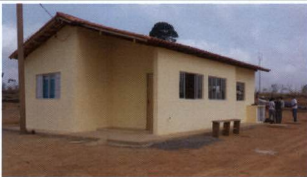
Foto 09 - Residência no RRC no Travessão 27.
