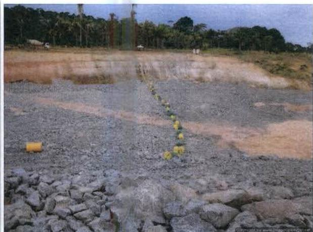
**Foto 18** - Canal auxiliar ao canal de derivação com corte exposto sem enrocamento. Presença de barreira para impedimento de embarcações.
