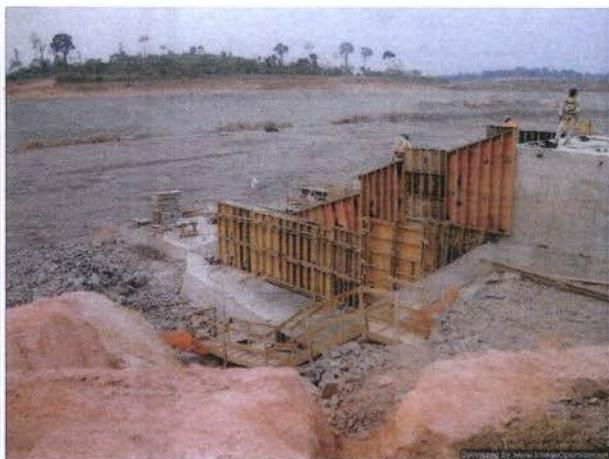
**Foto 17** - Galeria transposição igarapé junto ao canal de derivação.
