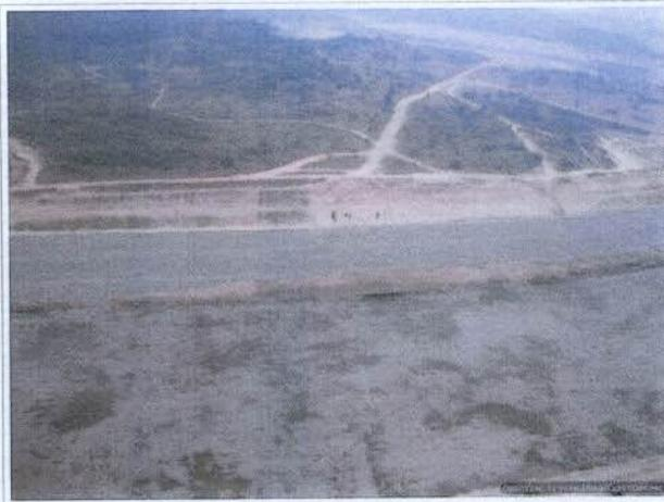
**Foto 19** - Sulcos erosivos em cortes acima do enrocamento no canal de derivação.
