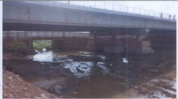
Foto 06: Ponte Rua João Coelho
