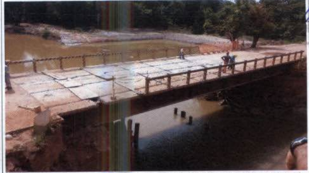
Foto 17 – Ponte antiga da Avenida Tancredo Neves sendo removida pela Norte Energia.
