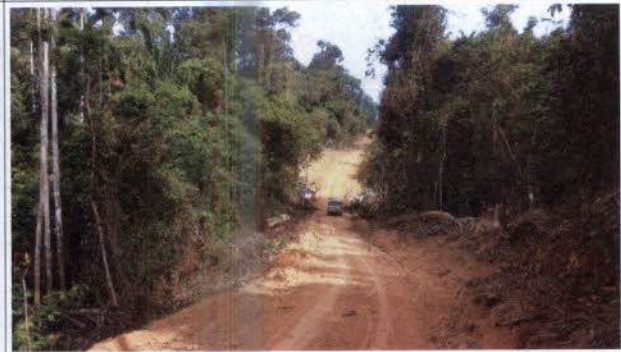
Foto 4 – Trecho do Setor Canal – acesso existente na faixa de servidão da LT 230 kV.
