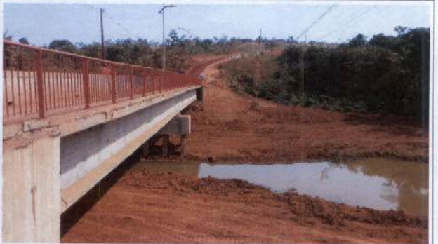
Foto 13 – Ponte Rodovia Transamazônica (igarapé Altamira).
