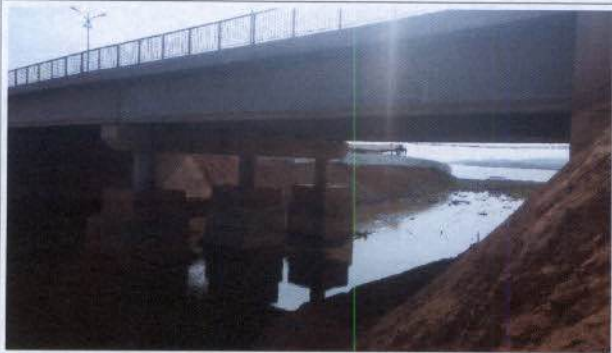
Foto 10 – Ponte Coronel José Porfirio (igarapé Altamira).
