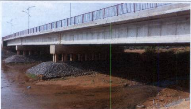
Foto 12 – Ponte Rua Goldim Lins (igarapé Altamira).
