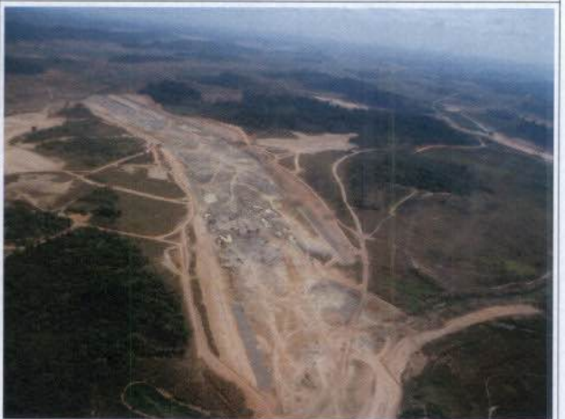
Foto 29 – Obras ainda em implantação no Canal de Derivação (fim do Canal no encontro com o reservatório Intermediário).
