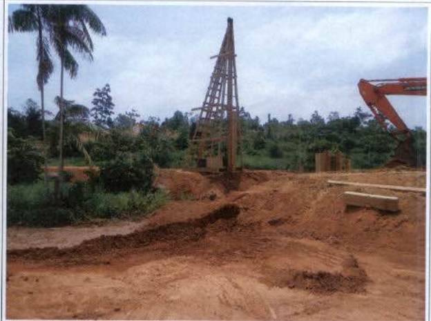
Foto 25 – Implantação de ponte no RRC.
