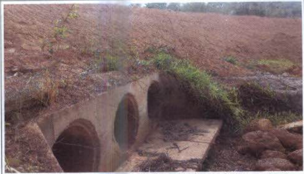
Foto 2 – Tubulões instalados no Trecho 1 do Setor CEA.
