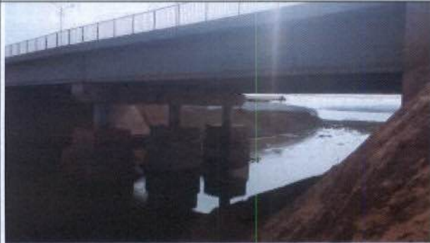
Foto 05: Ponte Coronel José Porfírio
