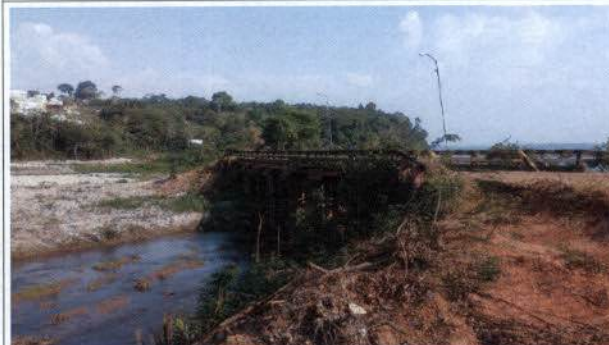
Foto 22 – Ponte de madeira que ainda deve ser retirada na foz do igarapé Ambé.
