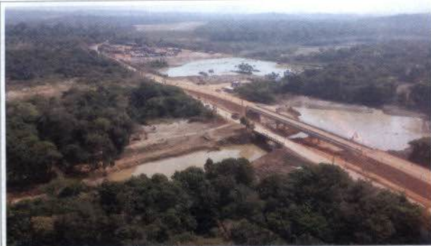
Foto 16 – Ponte Avenida Tancredo Neves.
