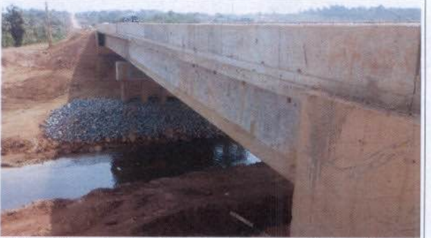
Foto 15 – Ponte Rodovia Transamazônica (igarapé Ambé).
