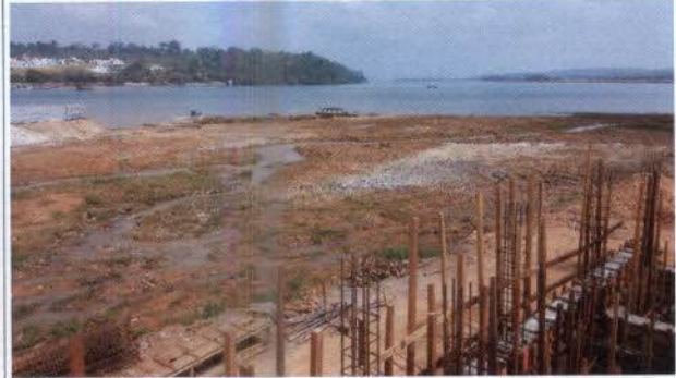
Foto 19 – Limpeza e nivelamento da calha na foz do igarapé Altamira.
