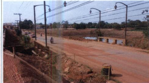
Foto 23 – Ponte antiga na rua Goldim Lins que ainda deve ser retirada.
