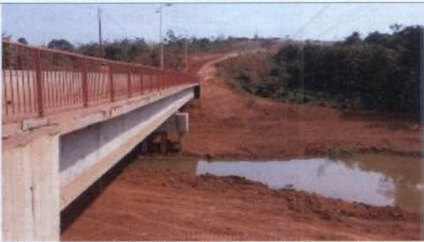
Foto 08: Ponte Rodovia Transamazônica (Altamira)
