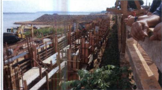
Foto 21 – Píeres sendo implantados na orla de Altamira.
