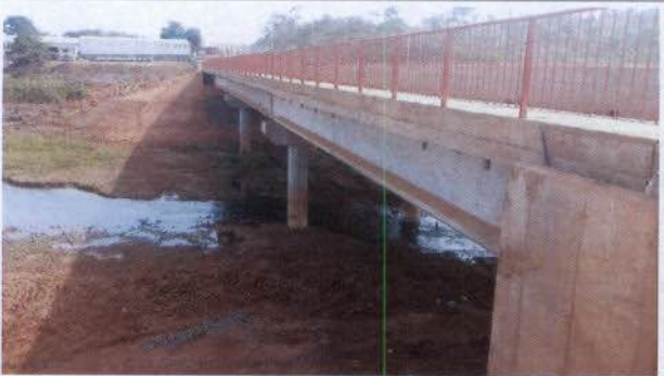
Foto 14 – Ponte Rodovia Ernesto Alcioly.
