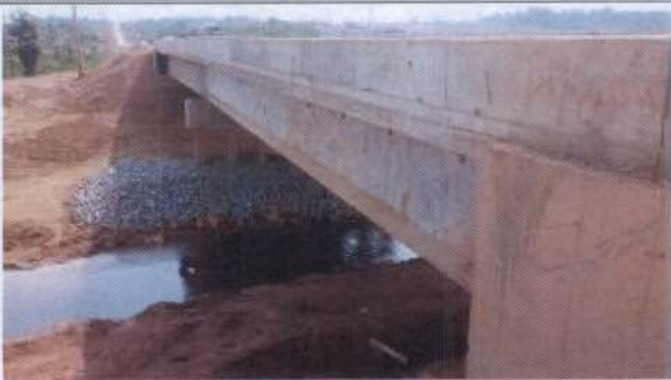
Foto 10: Ponte Rodovia Transamazônica (Ambé)
