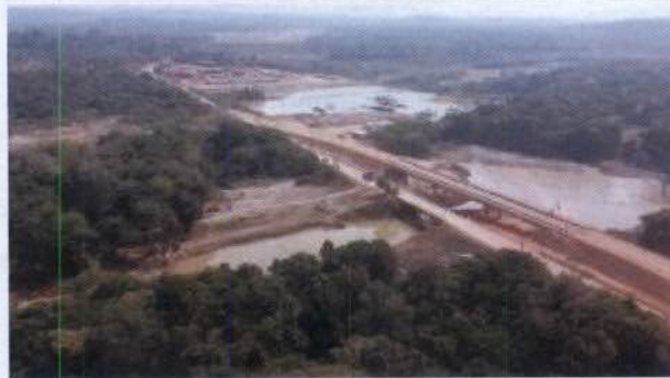
Foto 11: Ponte Avenida Tancredo Neves
