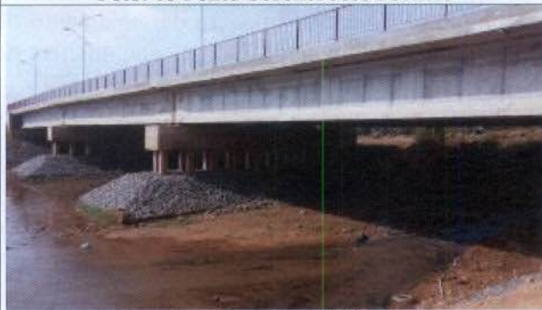
Foto 07: Ponte Rua Goldim Lins
