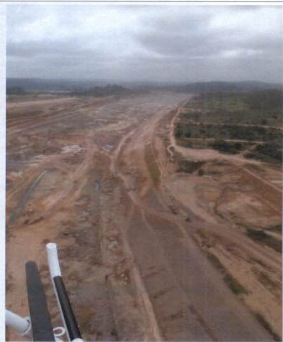
Foto 6: Setor onde o canal de derivação ainda encontra-se não finalizado.
