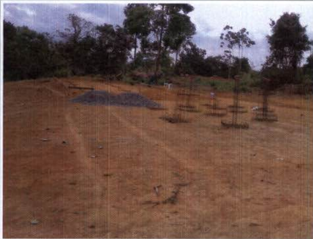
Foto 47 – Estágio inicial de casa na outra parte do RRC.
