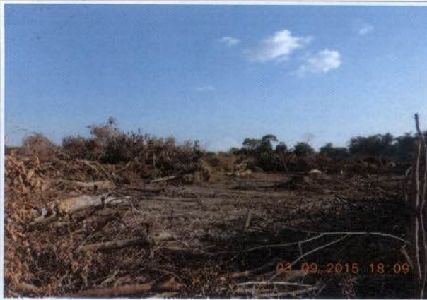
Foto 67 – Área com queimada e enterrio de material, com presença de resíduo grosso junto ao material a ser queimado (reservatório Xingu).
