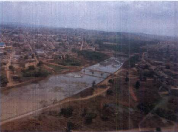
Foto 12 – Readequação da calha do igarapé Altamira.
