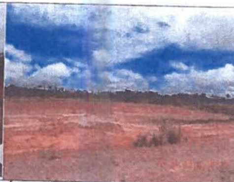
Área suprimida para obras civis no RI, com decapeamento do solo
