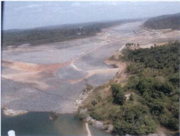
Foto 40: Vista da entrada do Canal com obras a serem finalizadas ao fundo.
