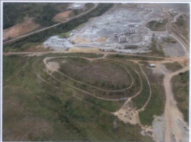
Foto 19: Bota fora 03/06 no sitio Belo Monte.
