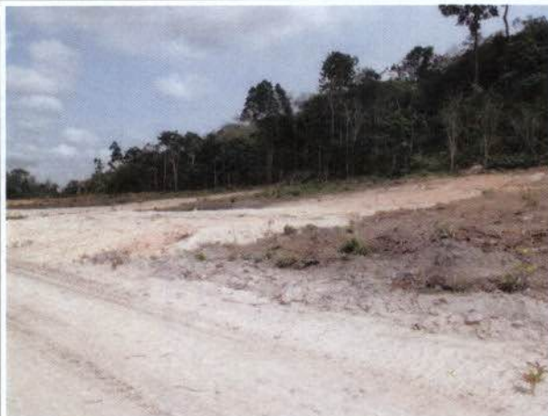
Foto 24: Supressão na margem direita do Rio.
