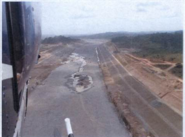
Foto 41: Vista do Canal obras a serem finalizadas.
