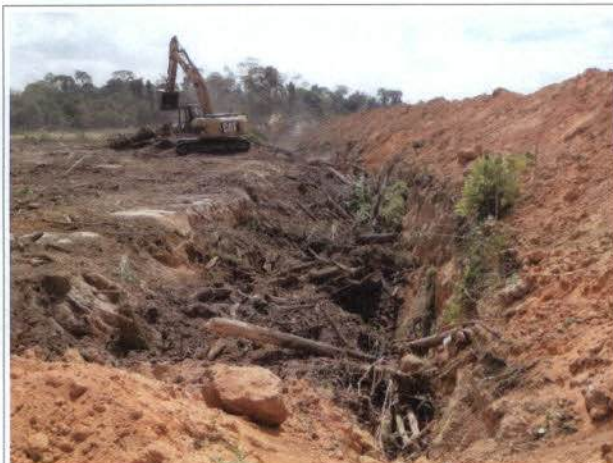
Foto 44: Enterrio de resíduos no lote G.
