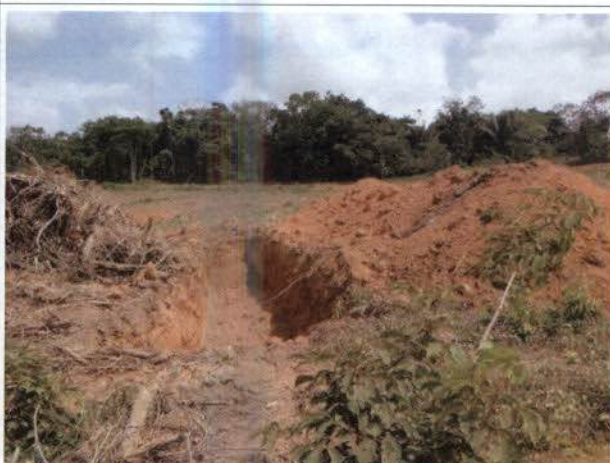
Foto 37: Vala aberta para receber resíduos finos no RI no lote D.
