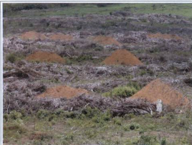
Foto 38: Área com valas abertas preparadas para o enterrio no lote D.
