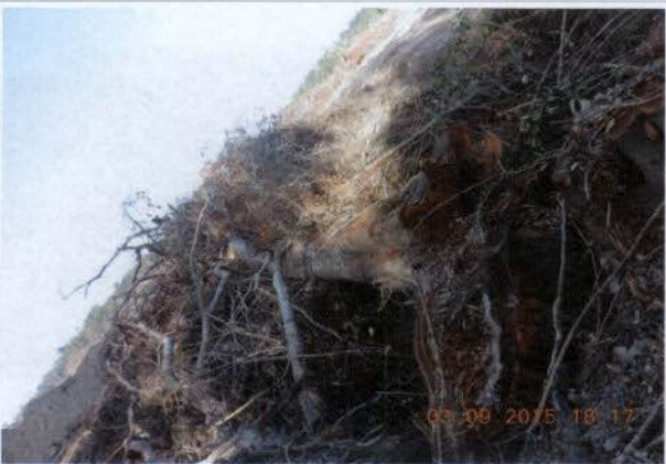
Foto 69 – Material sendo queimado fora da vala, com presença de resíduo grosso (reservatório Xingu).
