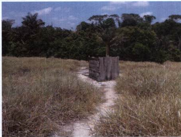
Foto 39 – Banheiro improvisado entre a casa e fonte d'água.
