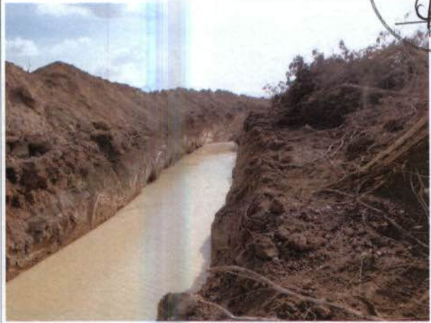
Foto 24: Vala cujo lençol freático elevou-se impedindo o enterrio de resíduos finos.
