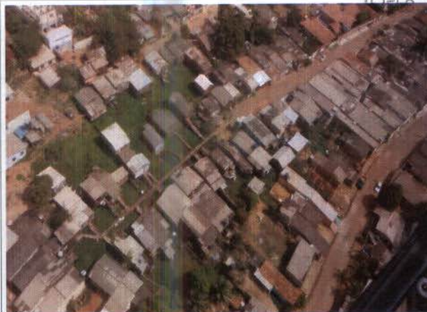
Foto 14 – Baixio do Bairro Independente II – presença de palafitas.
