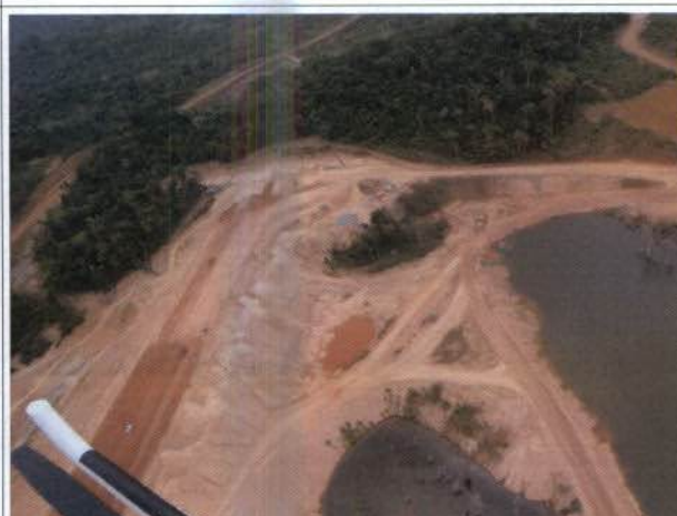
Foto 15: Dique de contenção do RI.
