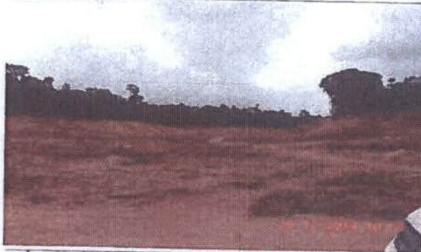
Área de Supressão no futuro reservatório (RI), após a retirada dos resíduos finos
