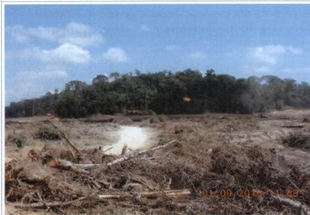
Foto 3 – Área em fase de segregação do material (margem direita do futuro reservatório Xingu).
