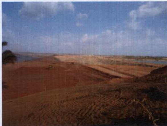
Foto 11 – Barragem do Canal Direito ainda sendo implantada no sítio construtivo Pimental.
