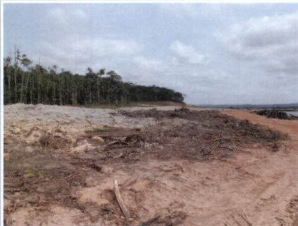
Foto 25: Supressão na margem direita do Rio.
