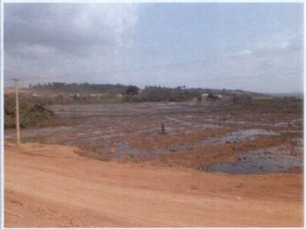
Foto 22: Supressão e limpeza do igarapé Pannels na zona urbana de Altamira.
