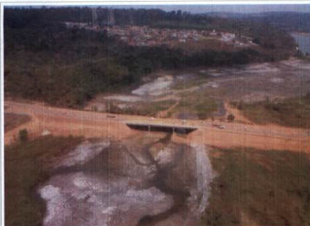
Foto 13 – Readequação da calha do igarapé Ambé.
