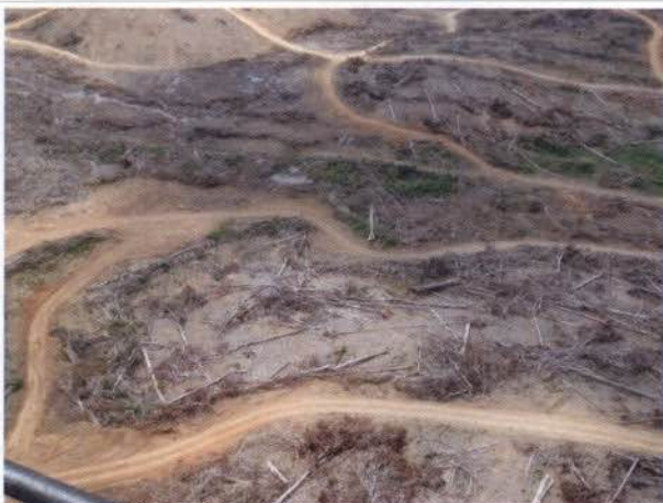
Foto 14: Área do reservatório intermediário que ainda deverá ser retirada e enleirado resíduos.
