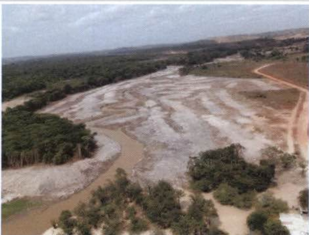
Foto 16: Supressão e limpeza do igarapé Ambé na zona urbana de Altamira.
