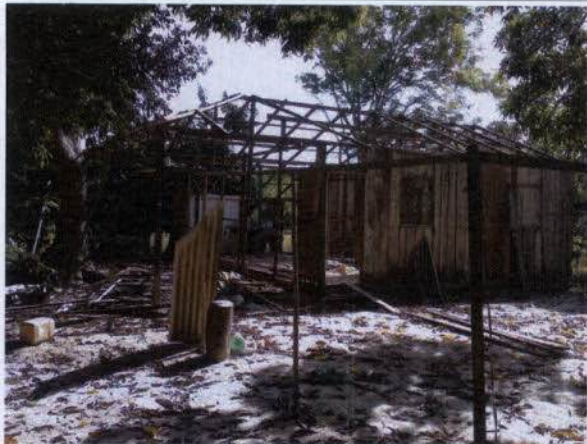
Foto 41 – Casa do Seu Dedé parcialmente demolida e transferida pelo próprio.
